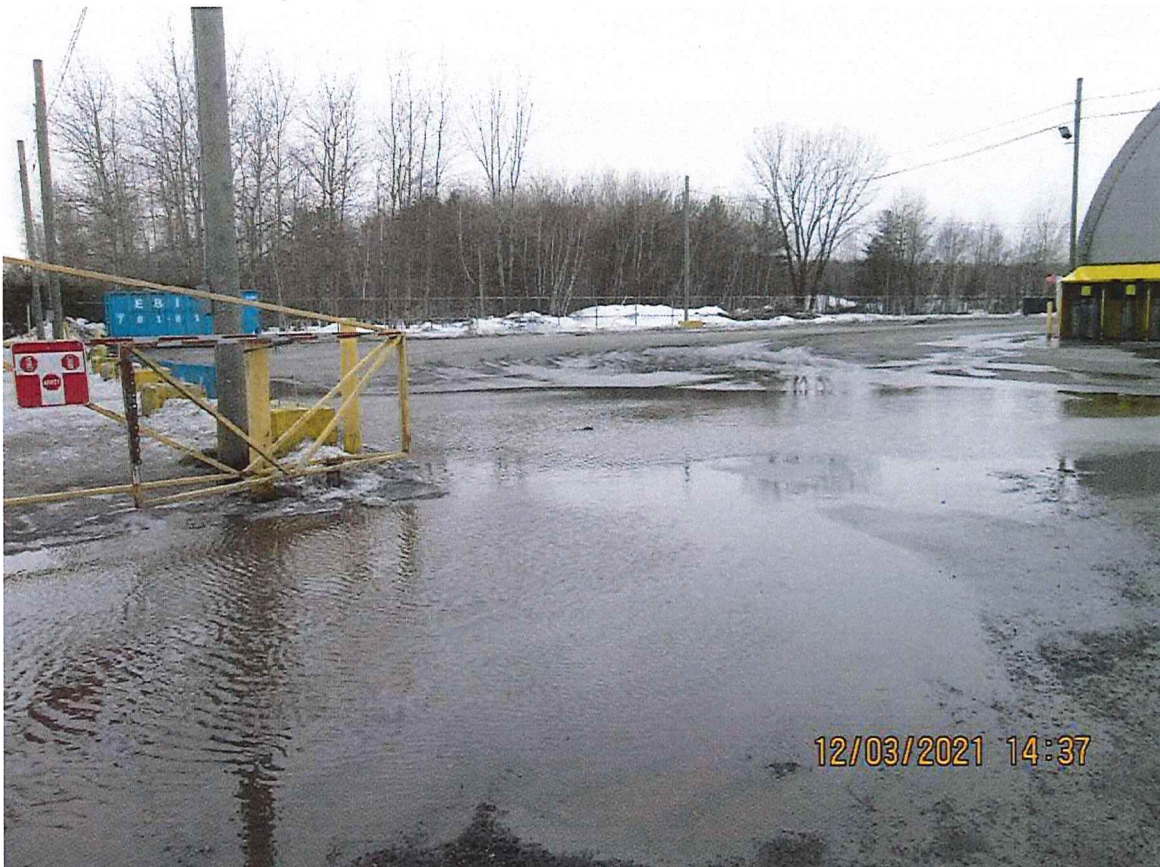
Photo 1: accumulation d'eau au-dessus d'un puisard poreux
