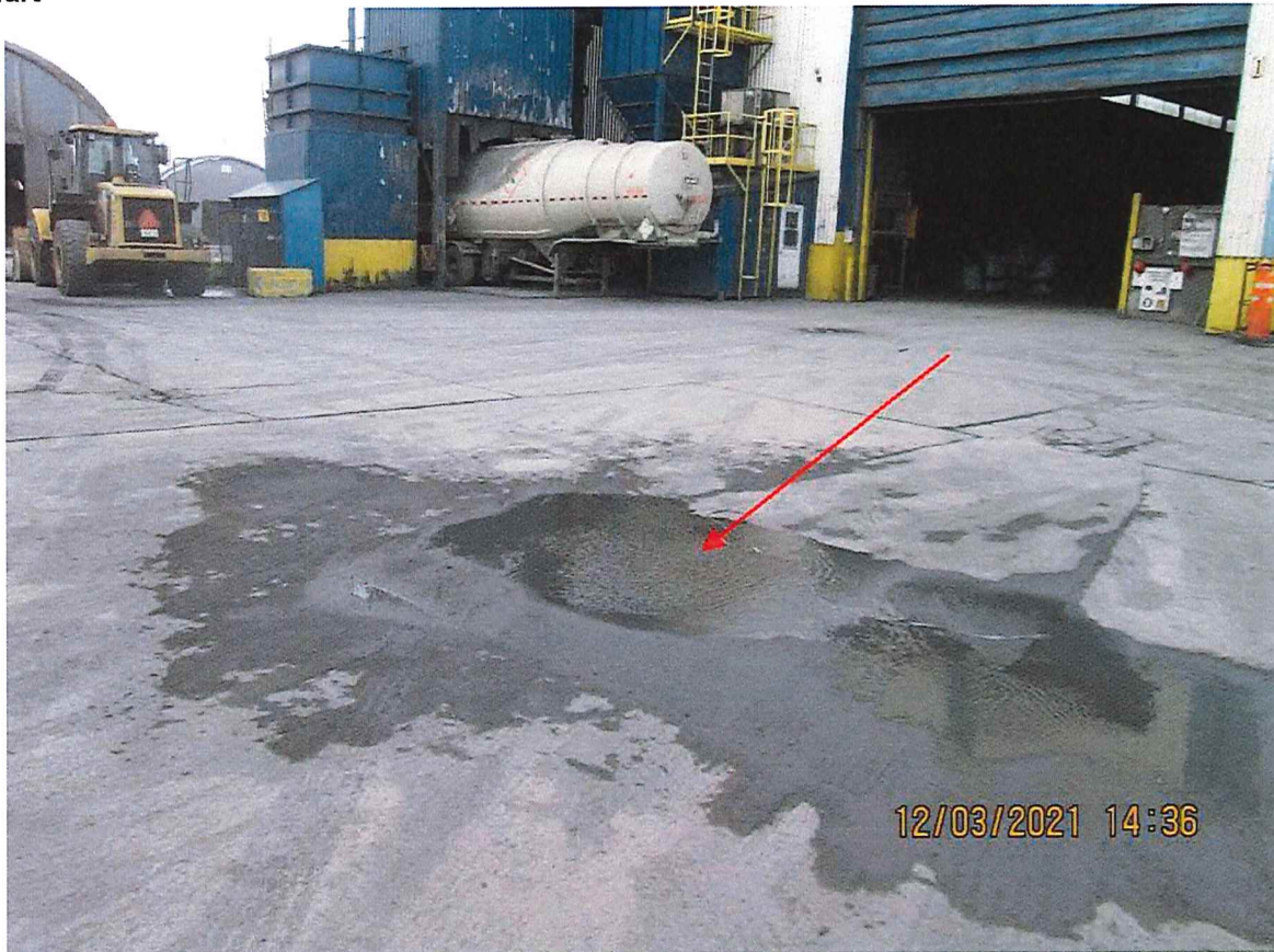
Photo 1: accumulation d'eau au-dessus d'un puisard poreux
