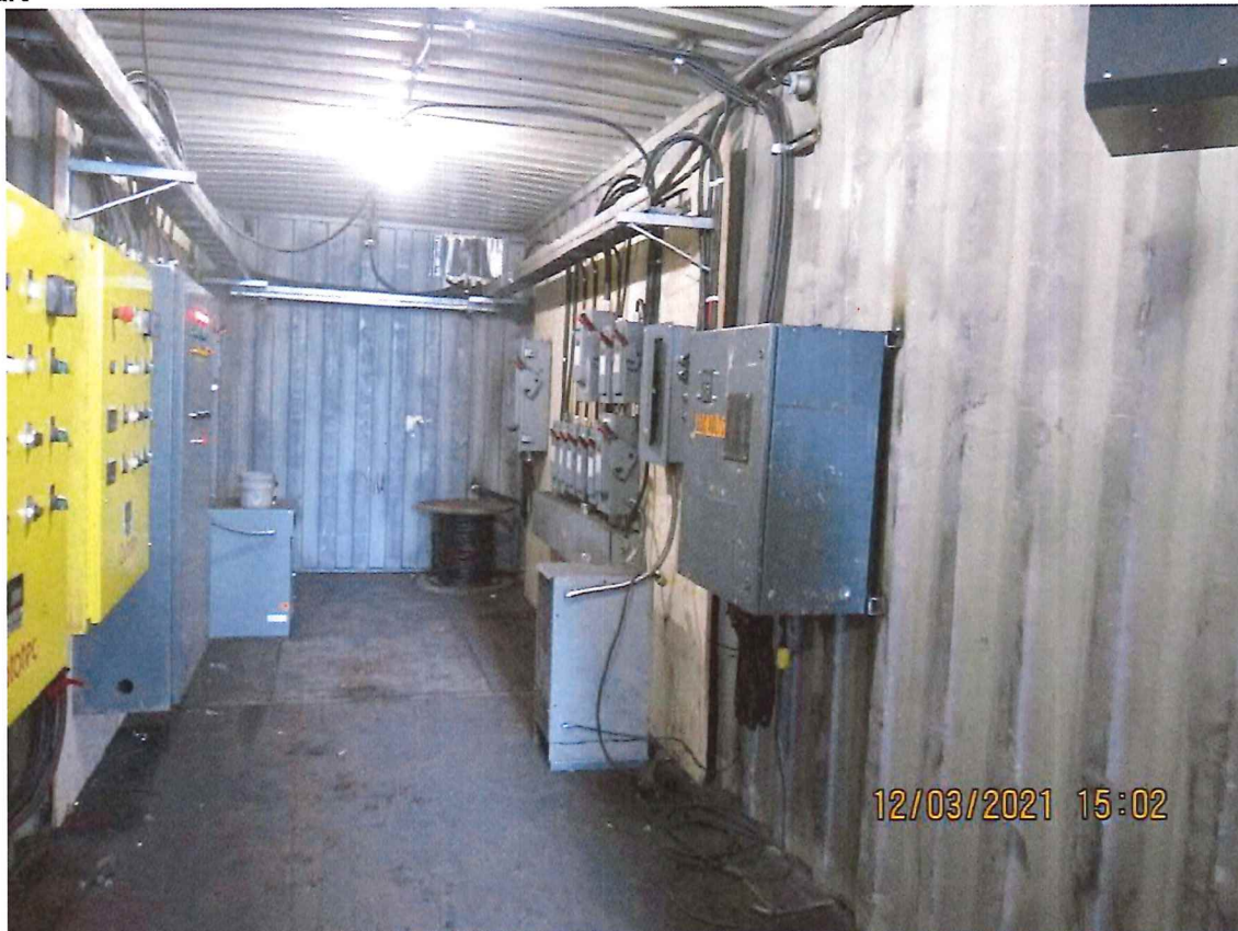
Photo 7: conteneur comprenant les panneaux de contrôle et système électrique (#2 sur photo 6)
