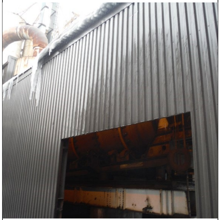
DSCF1833.JPG Photo 14: Abri du séchoir
