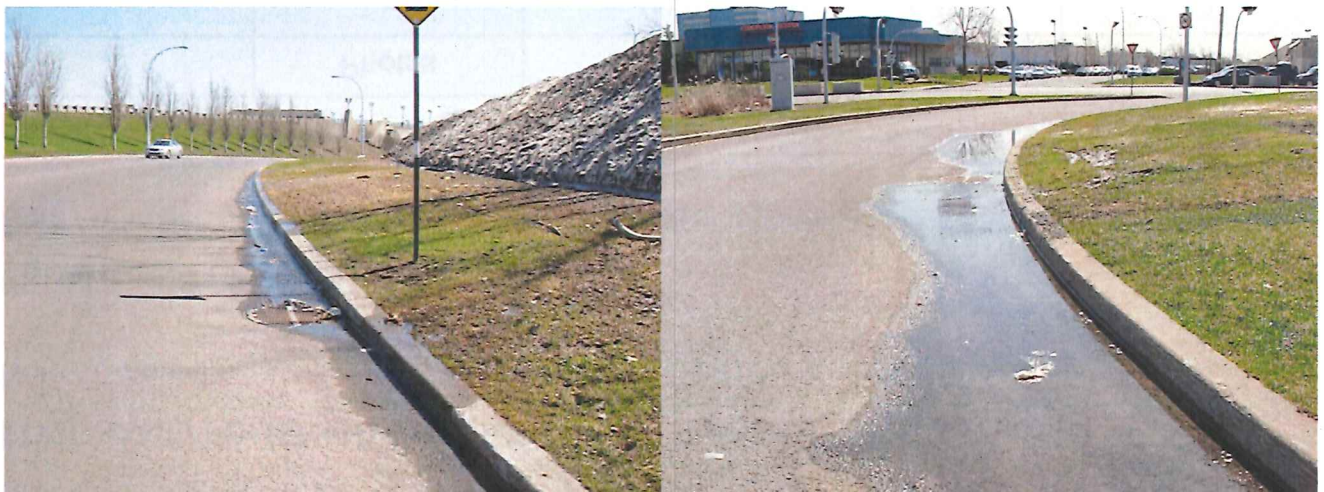
Photos 3-4 : Eaux se déversant dans le réseau d'égout de la rue Bord de L'eau .
