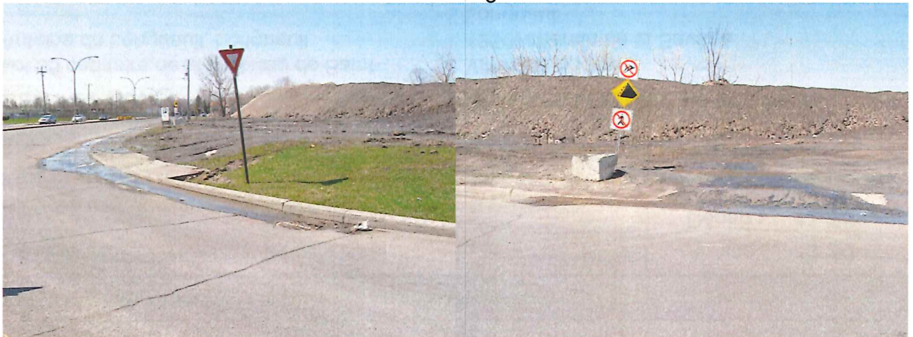
Photo 5 : Égout intersection Rue Bord de L'eau et Saint-Charles
