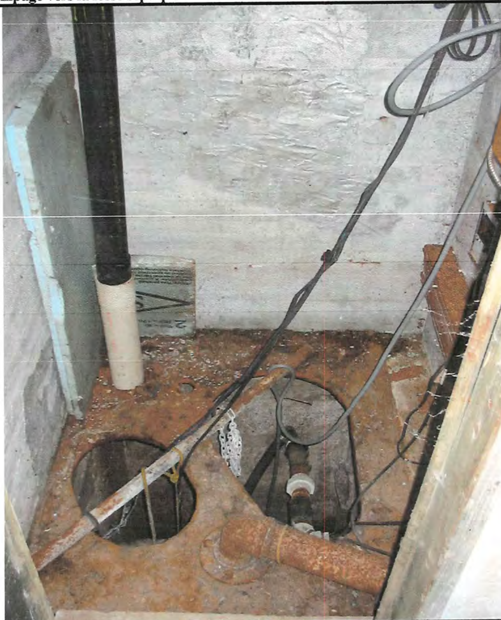
Photo # 4 : Référence Photo : 003.JPG Note : Station de pompage vers la fosse septique
