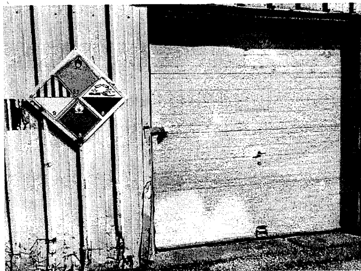
Photo 1 : IMG_0177.JPG Local de stockage des MDR - Fermé lors de l'inspection.
