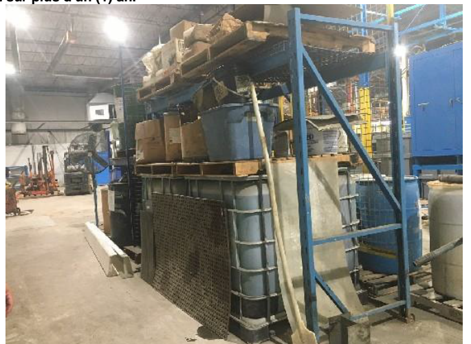
IMG_2075.jpg Photo 32 : Conditions d'entreposage de l'électrolyte de Nickel - Pas de bassin de rétention.
