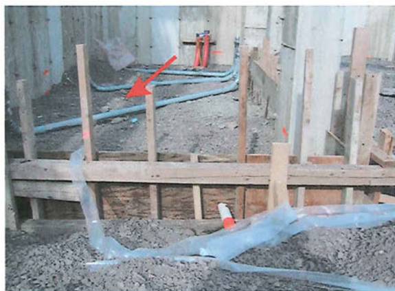
N° 5: Installation de conduites d'aération
