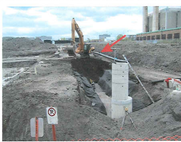
N° 4: Mise en place de la conduite d'égout de type SDR avec joints en nitrile (Rue Pauline-Julien)
