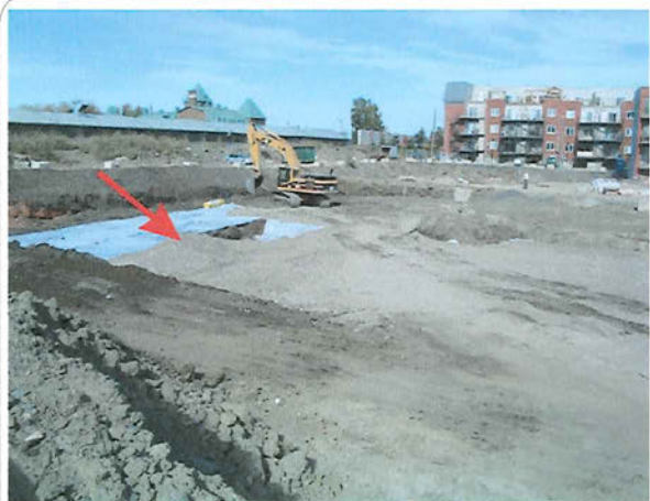
N° 3: Mise en place d'une membrane géotextile (bâtiment 4000/5000)
