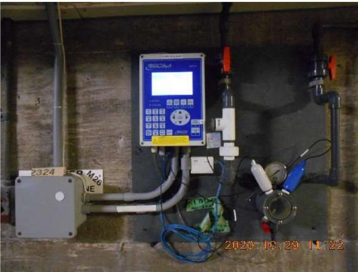
DSCN6881.JPG Photo 9 - Installation Becsys et robinet pour l'échantillonnage
