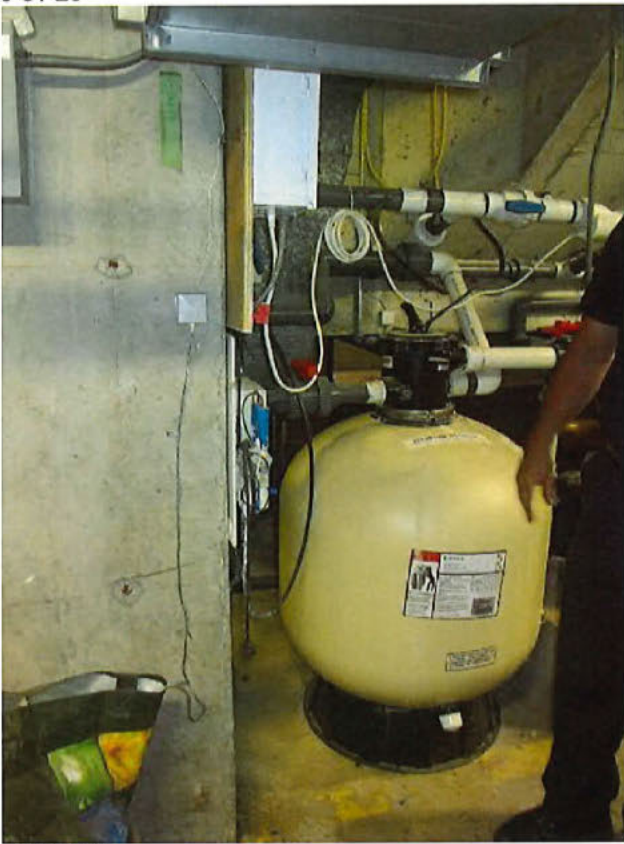
IMG_0007.JPG Accès à l'eau des piscines pour le prélèvement d'eau pour analyses
