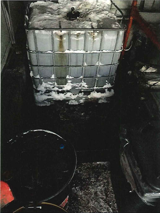
IMG_0368.jpg Photo 1 : bassin de rétention
