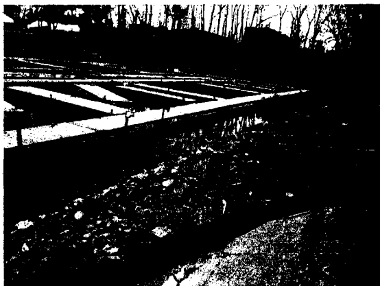
Suite de la vue d'ensemble, section passée le mur de béton IMG 018.jpg
