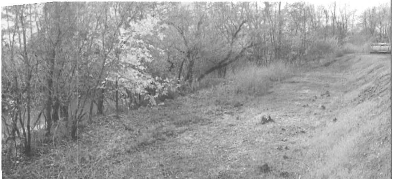
photo 1, DSCN5498, 5499, 5500 : Retrait des remblais en bande de protection riveraine et en plaine inondable, stabilisation du talus et des surfaces mises à nues par un ensemencement approprié. Vue vers l'amont.
