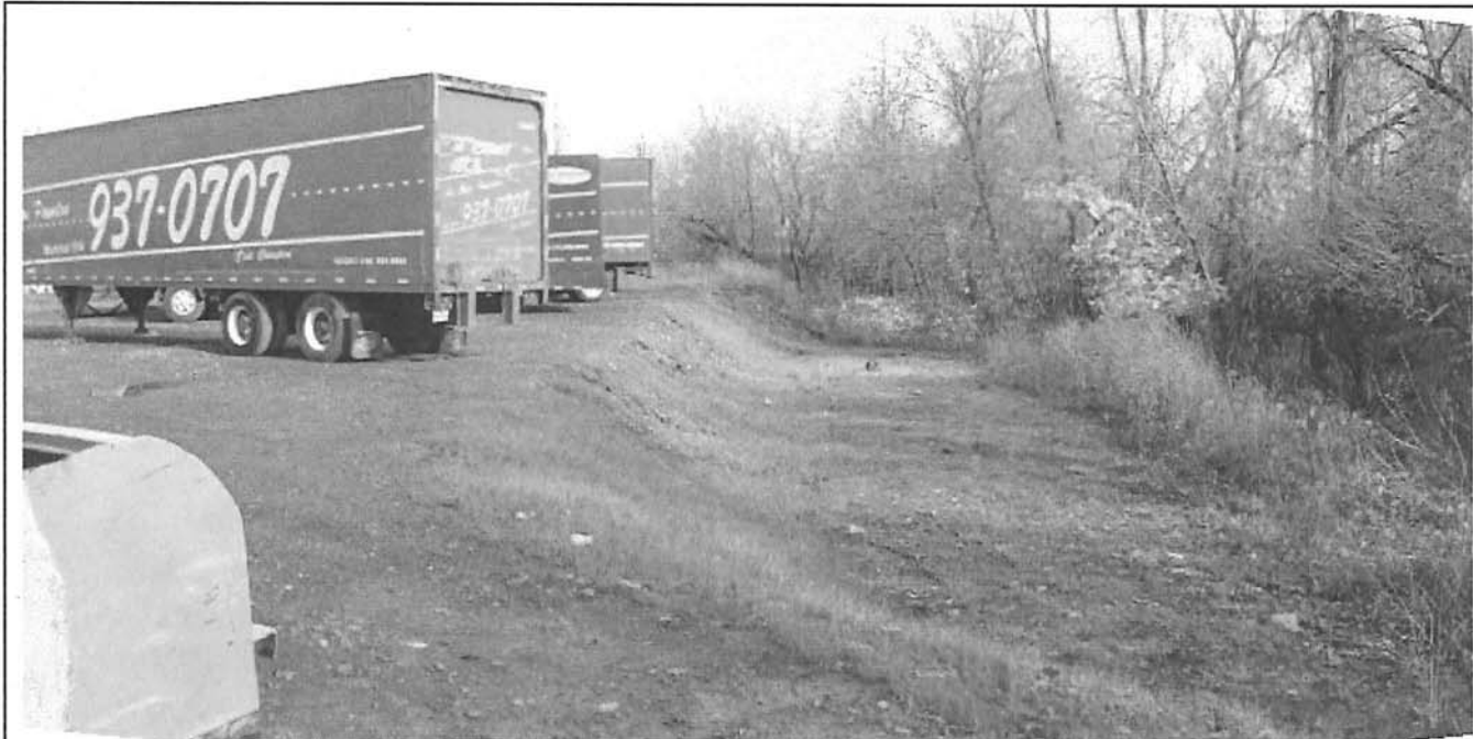
photo 2, DSCN5501, 02 : Retrait du remblai en bande de protection riveraine et en plaine inondable de la rivière Saint-Jacques, ensemencement des surfaces. Vue vers l'aval
