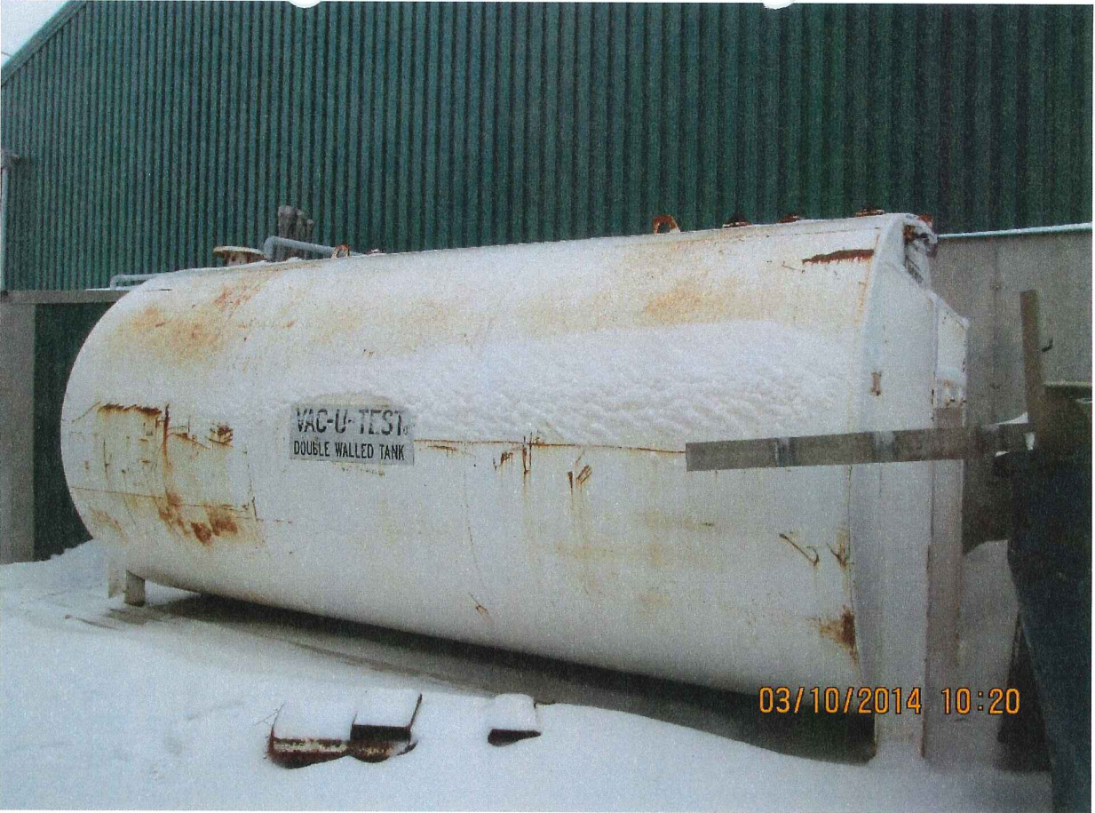
Photo # 1 (IMG_0138.jpg) : Réservoir non utilisé (Côté Lorbec)
