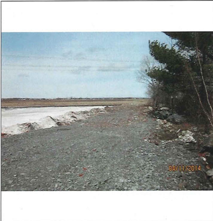
IMG_0293 (Small).jpg Fin du remblai
