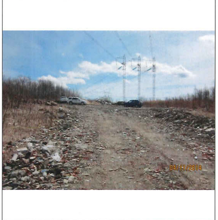
IMG_0306 (Small).jpg Début du remblai à l'entrée du rang St-Laurent
