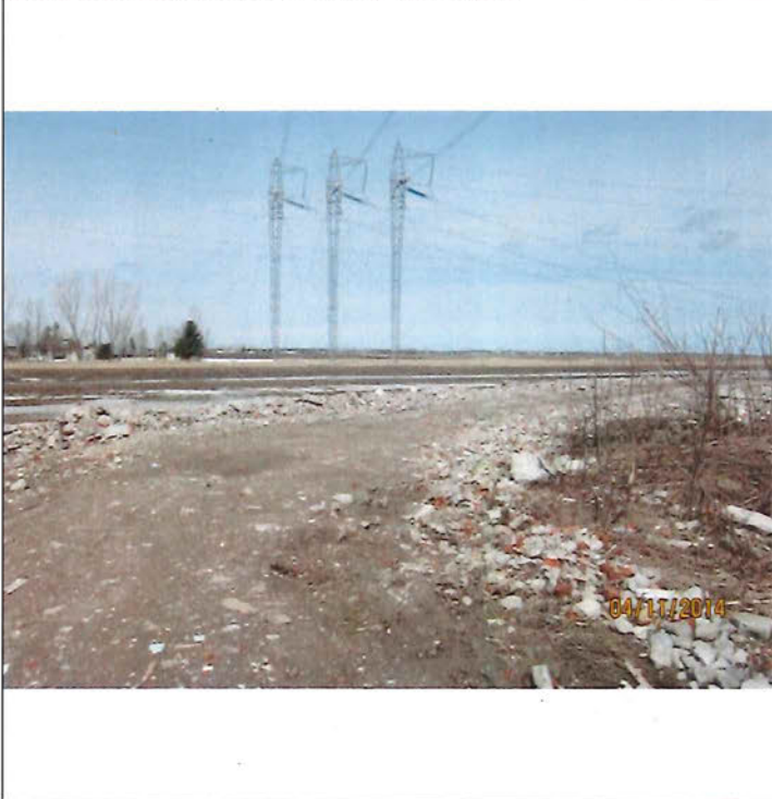
IMG_0307 (Small).jpg Remblai de DCD
