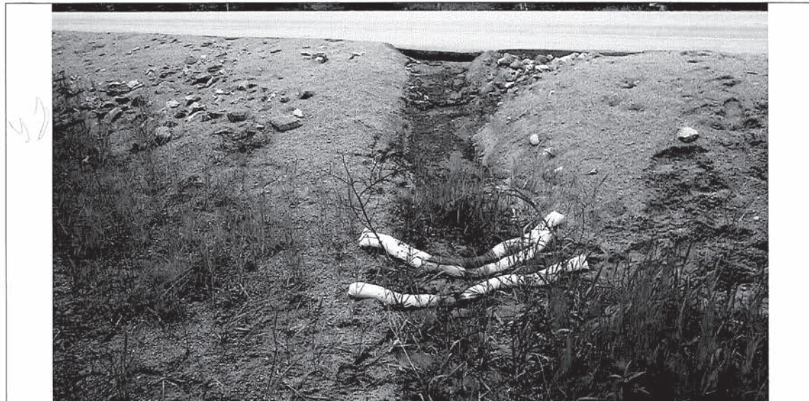
Photo 12 Présence de boudins absorbant dans l'accotement de la route
