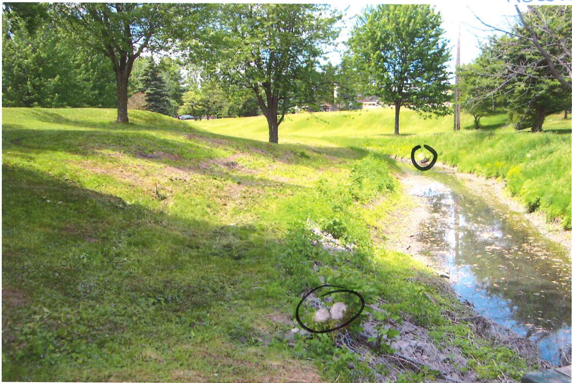
photo 4 : Vu de la rive où il y a eu des Travaux.
