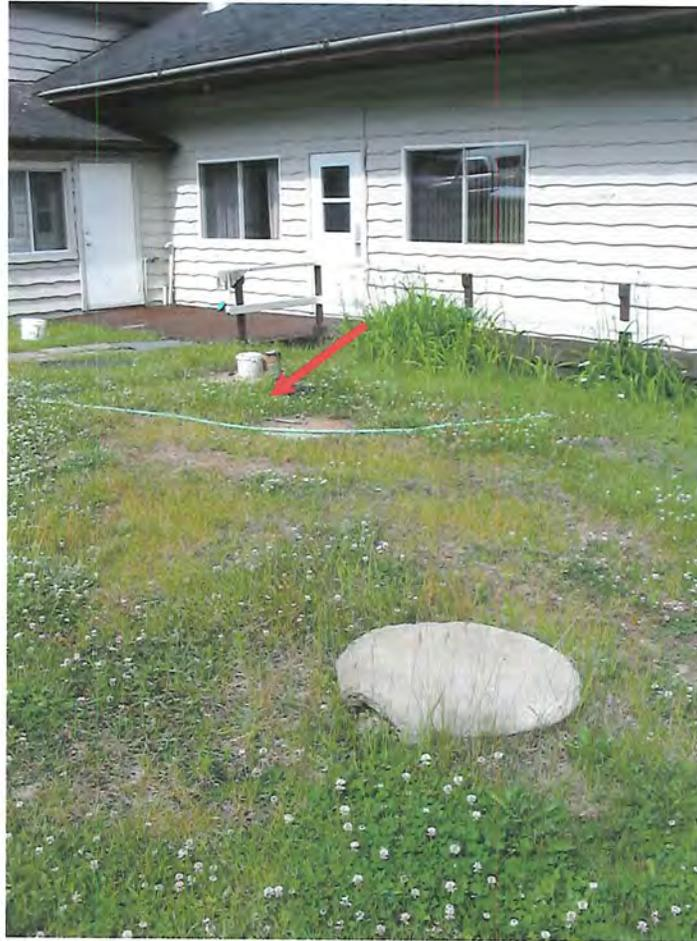
**Photo no. 1 :** Deux couvercles de la fosse en béton. La flèche rouge localise le couvercle de la trappe à graisse.
