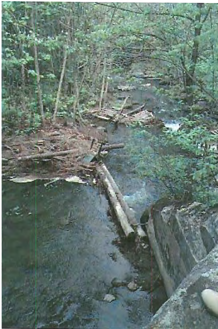
Photo 4 Le ruisseau au fond de la dépression. Un ponceau de béton permet au ruisseau de s'écouler sous l'ancienne voie ferrée devenue piste cyclable.
