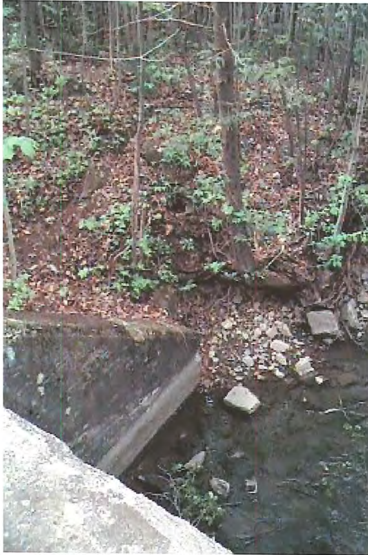
Photo 5 Même ruisseau et ponceau. L'effluent du dépôt de sel sera situé à la base du pilier de béton.
