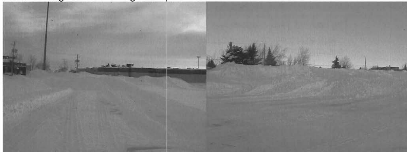
Photo 3-4 : Signe qu'il y a eu déblai de neige par la gratte.
