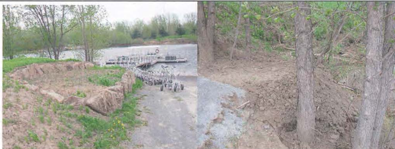
Photo 9 : Pierres installées en rive du côté est de la descente.
