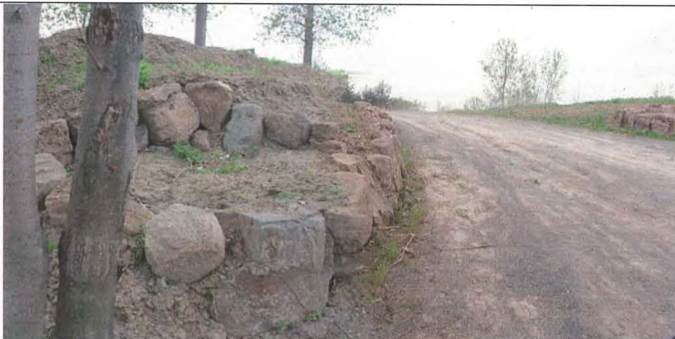
Photos 3 et 4 : Travaux d'aménagement paysager réalisés de part et d'autre de la descente; pierres mises en rive (vue sur la rive à l'ouest de la descente).
