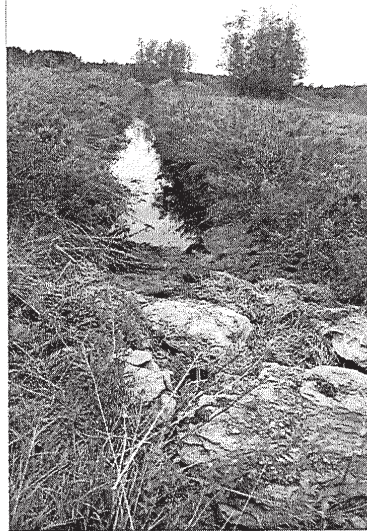
P1080876 (800x533).jpg Image 8. Vue du seuil construit aux coordonnées 45,846383°N / - 72,013135°O (waypoint 1106), dans la tourbière (à l'extérieur du cours d'eau)
