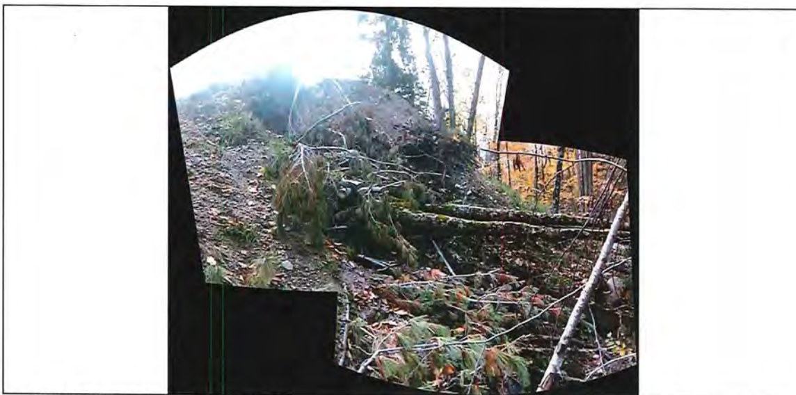
afb93386-0c73-46b6-b11e-53a48fda9fbc Panorama.jpg Débris végétaux dans le talus du remblai à la limite nord, vue direction sud-ouest
