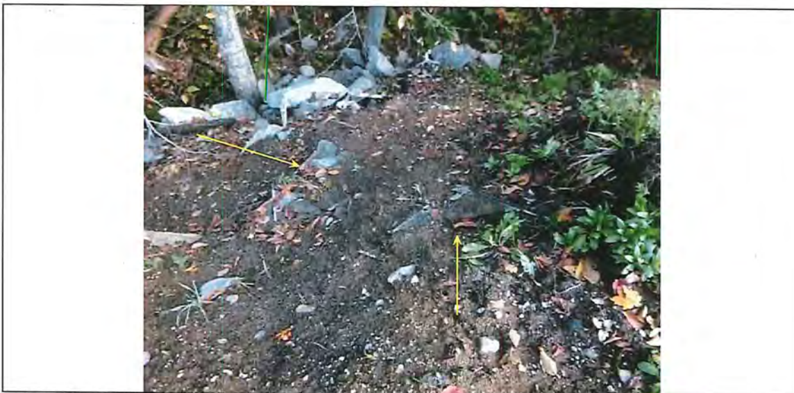
ec637515-e618-4318-8308-0a8dad7eaa5 vitre(2).jpg Verre cassé (flèches jaunes) et pierres au travers du remblai, marécage partie est (vert), vue direction nord-est
