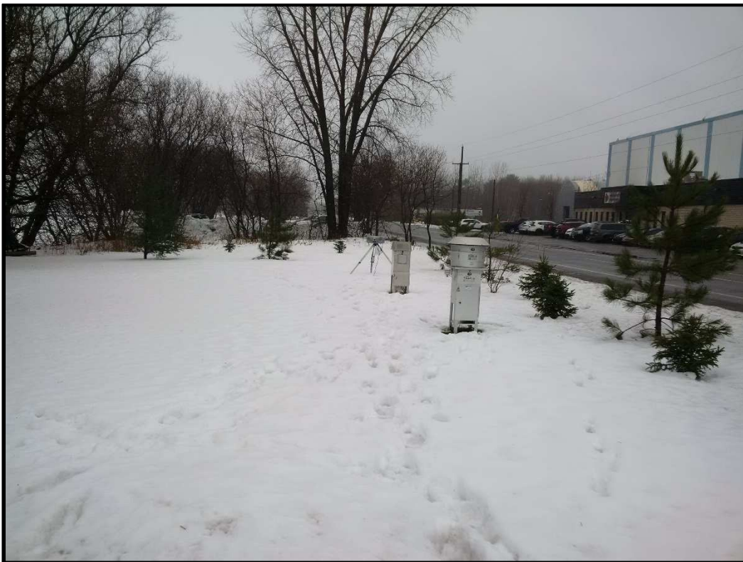
Photographie 4 : Station ST2, 205, rang Nord, lors de la désinstallation.
