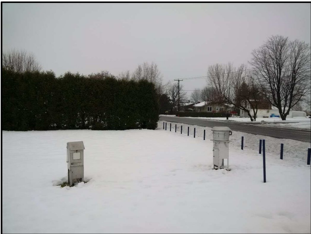
Photographie 8 : Station ST4, 175, rang Nord, lors de la désinstallation.
