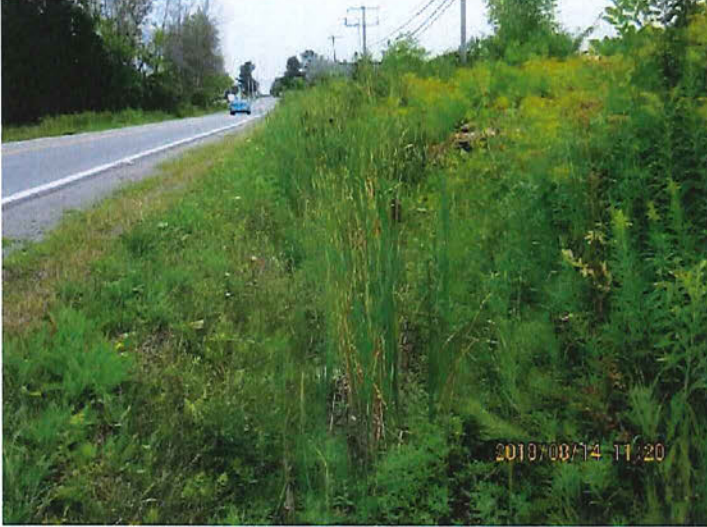
photo 7 fossé du rang du cordon
