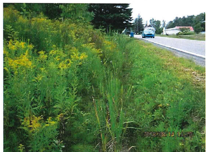
photo 6 fossé du rang du cordon
