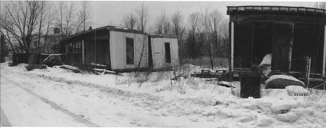
IMG_1018 Panorama.jpg 17-Partie restante de roulotte de chantier (nord-ouest)
