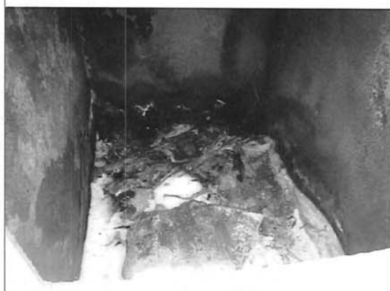
IMG_1023.JPG 12-Traces de brûlage à l'intérieur du foyer
