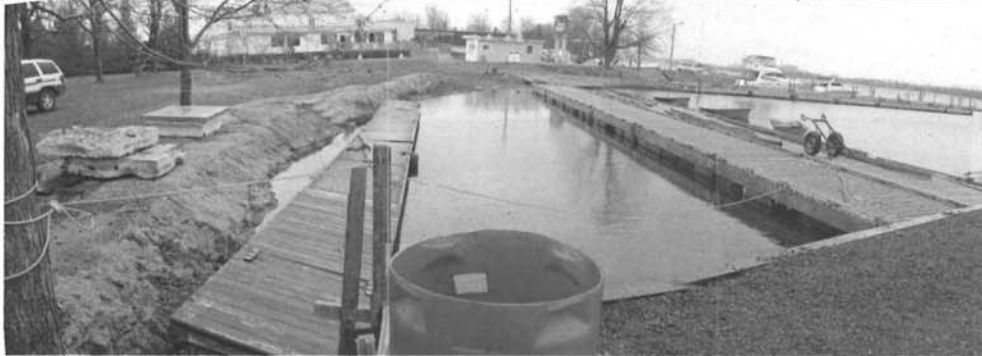
Photo 4 : Pan 36 à 38. 28 avril 2009. Ici on voit le talus riverain bétonné et le chemin de circulation riverain où il y a eu ajout de gravier. Au loin, quai à l'usage exclusif de Performance Marine.
