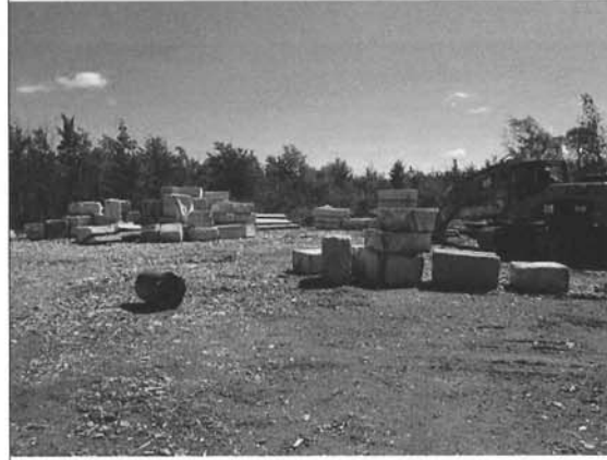
IMG_0424 (Small).jpg Blocs de béton, remblai de DCD au sol
