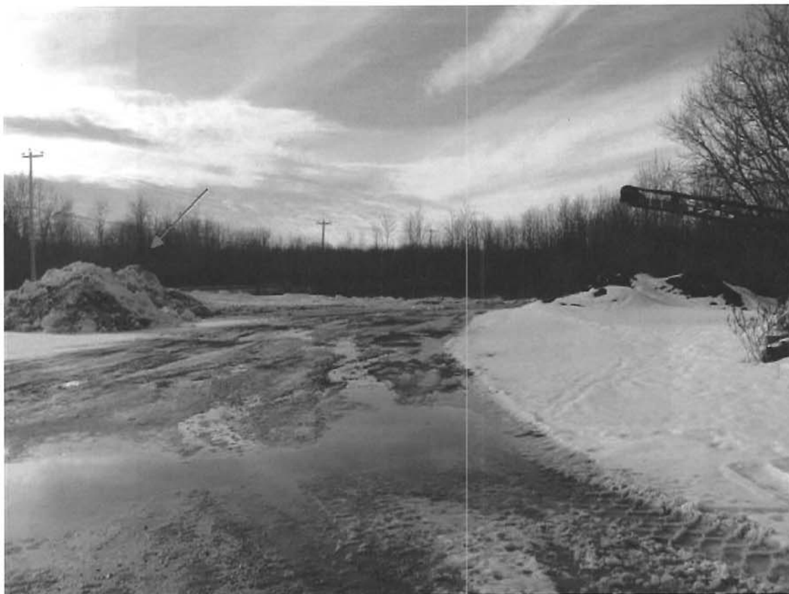
lpadMArcENVIRONNEMENT 005 (Small).JPG Amas de neige entreposé hors des rives du ruisseau Scully
