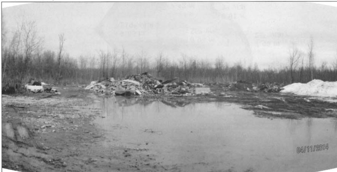
panorama3.JPG Matériaux brûlés, bois, gypse, carton, ect.
