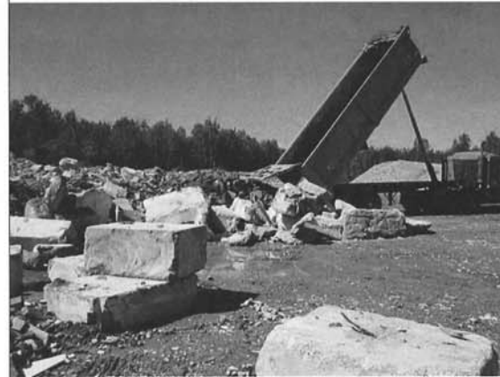
IMG_0428 (Small).jpg Camion dépose des DCD
