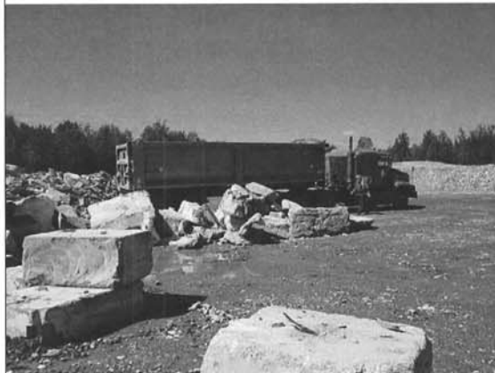
IMG_0425 (Small).jpg Camion dépose des DCD
