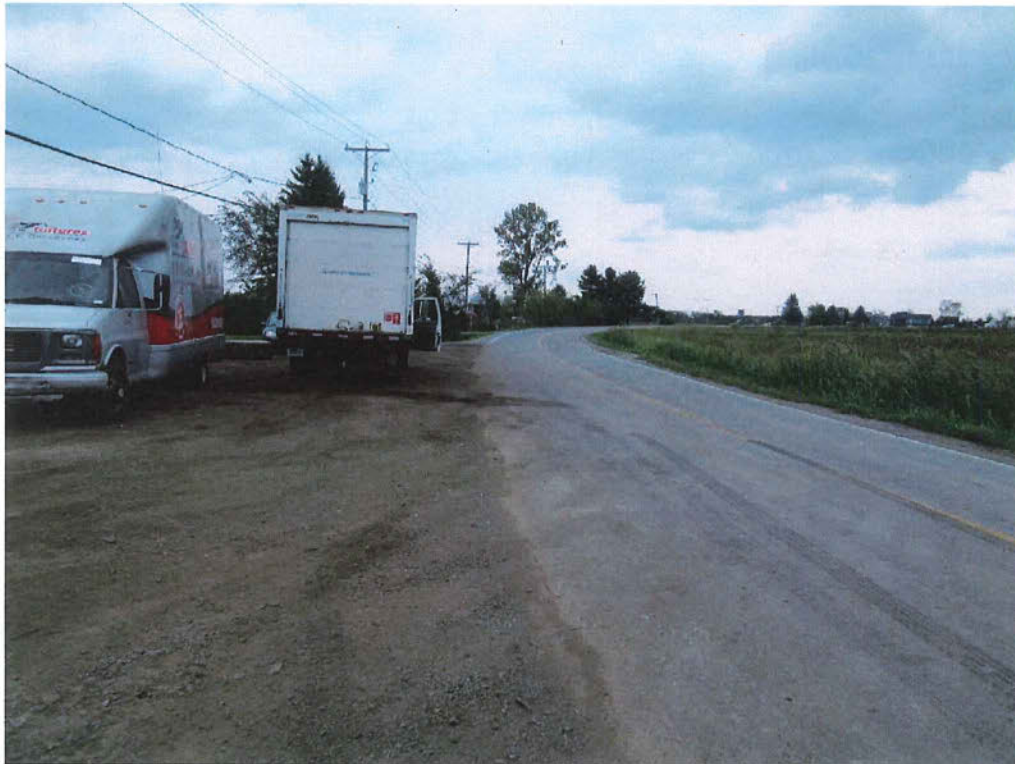
photo 001.jpg : la chaussée était exempte de déchets au moment de l'inspection.
