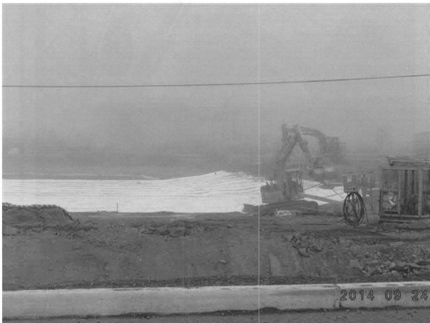
DSC02120 (Small).JPG Aménagement du bassin de rétention 2
