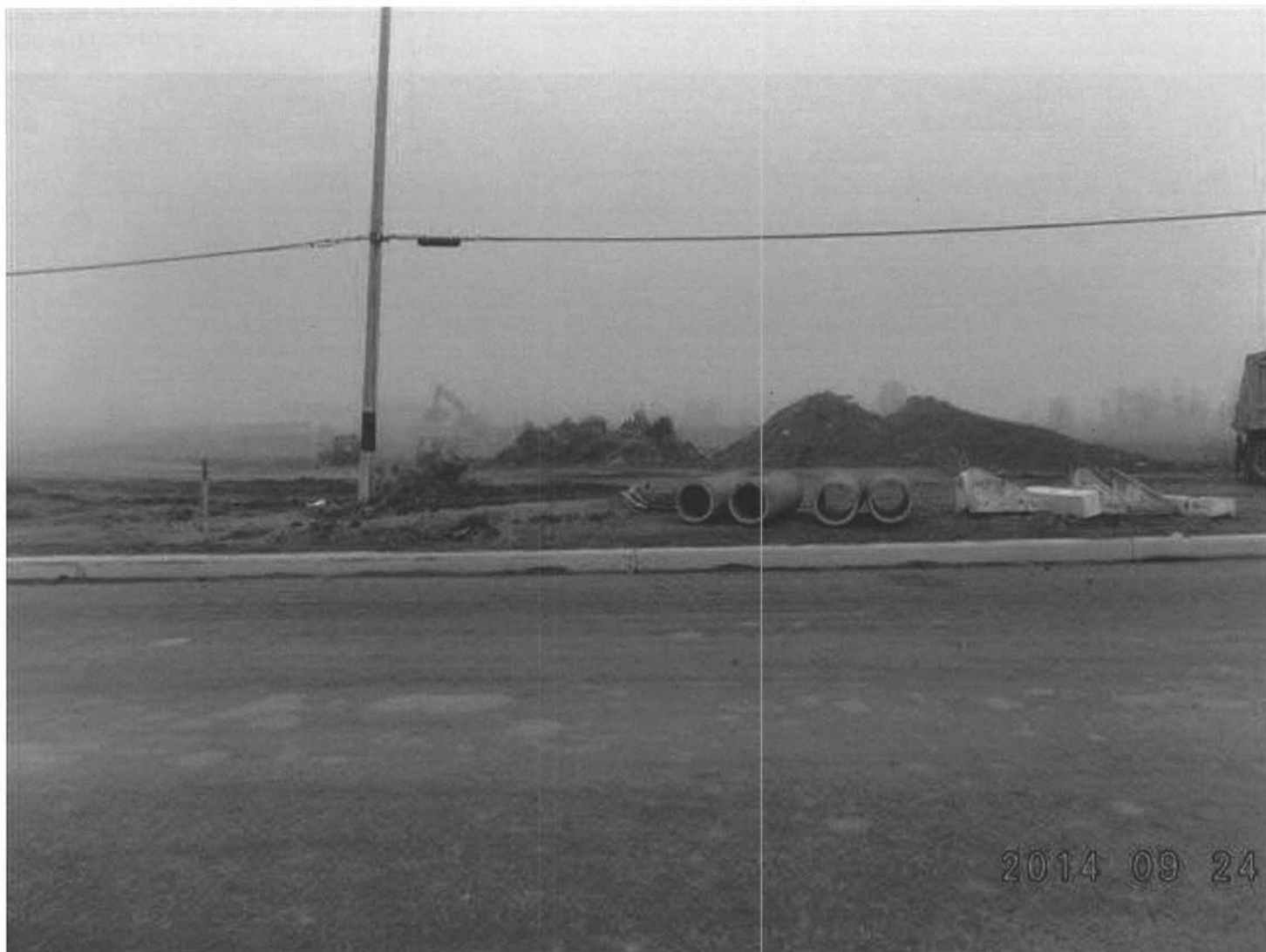
DSC02122 (Small).JPG Travaux d'aménagement de la rue B
