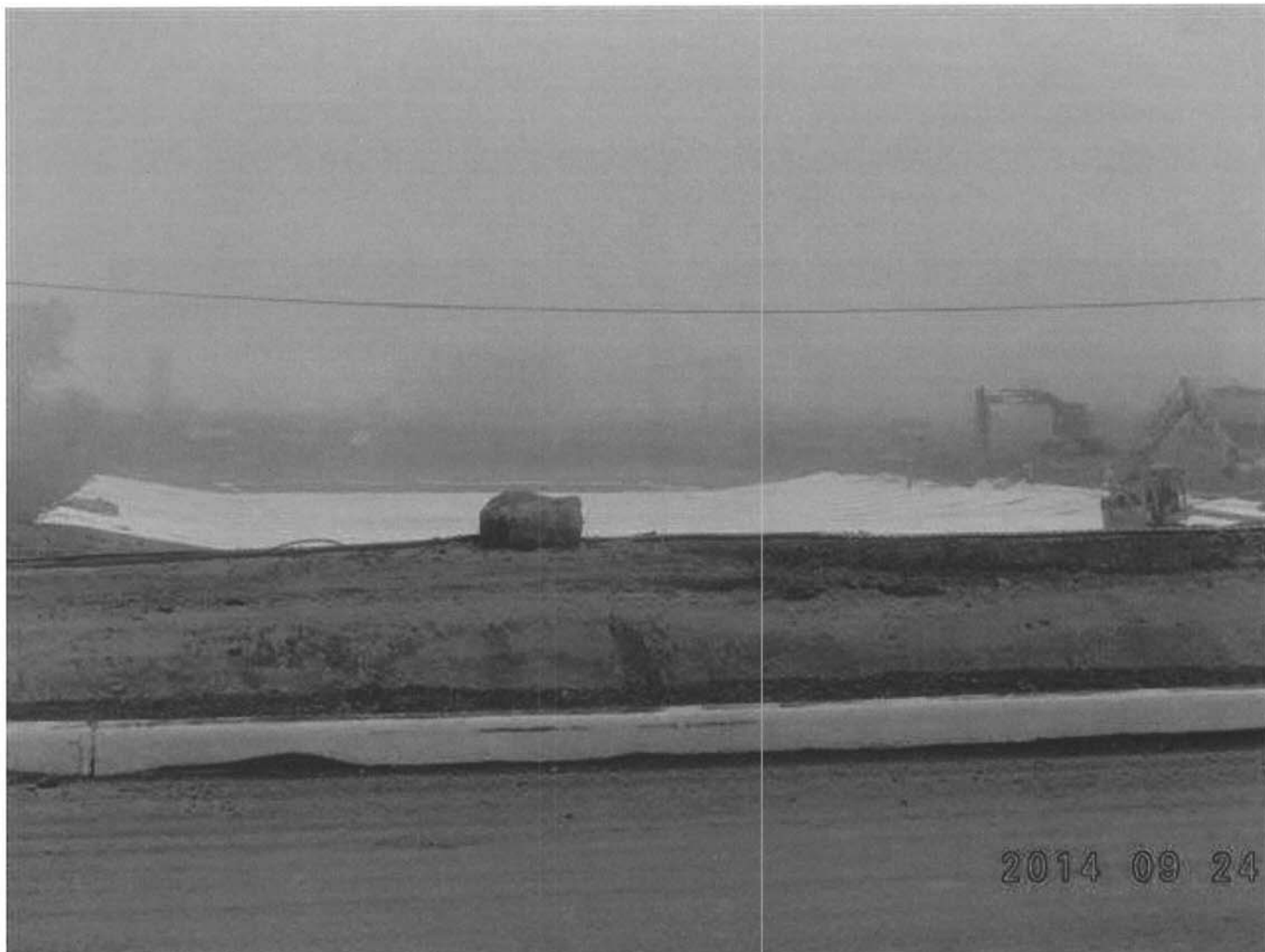
DSC02119 (Small).JPG Aménagement du bassin de rétention 2
