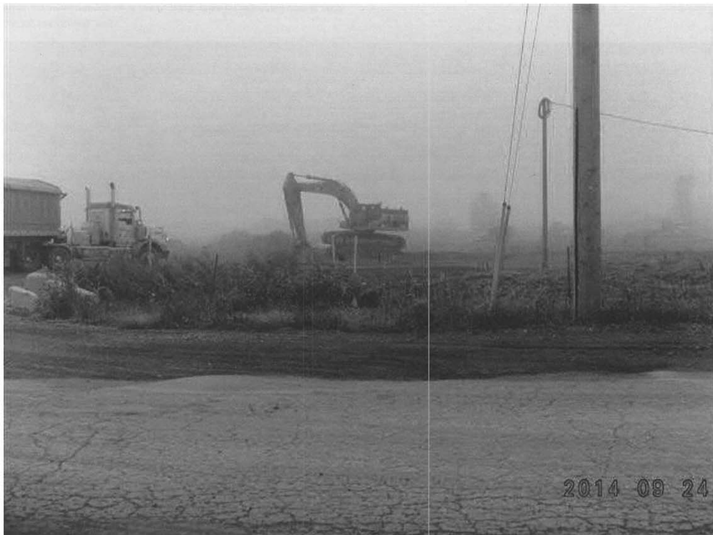
DSC02123 (Small).JPG Travaux d'aménagement de la rue B
