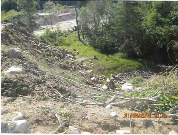
Photo 1 : IMG_2893.JPG Érosion de roches vers la sablière
