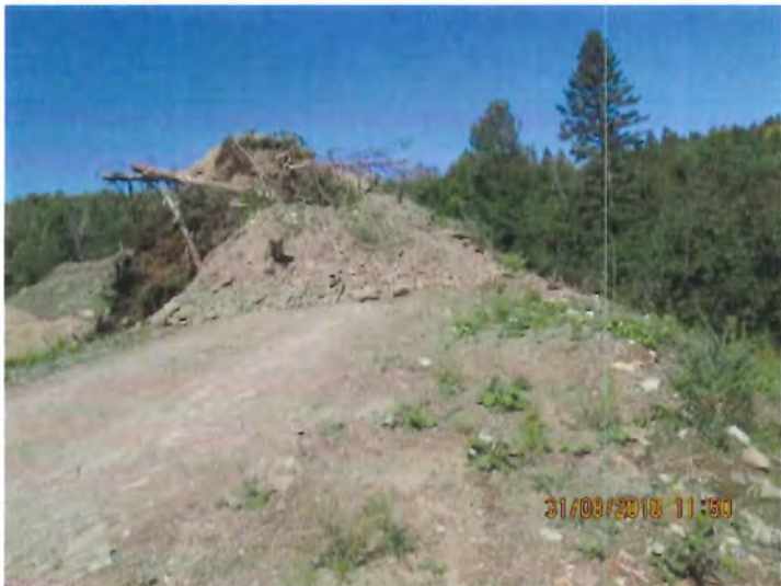
Photo 13 : IMG_2916.JPG Section aval du talus du nouveau chemin d'accès.
