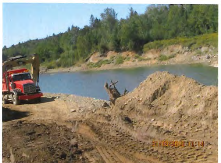
Photo 6 : IMG_2901.JPG Pelle mécanique à la limite des étangs.
