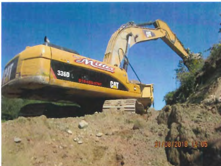
Photo 16 : IMG_2926.JPG Pelle mécanique utilisée pour les travaux en rive des étangs.
