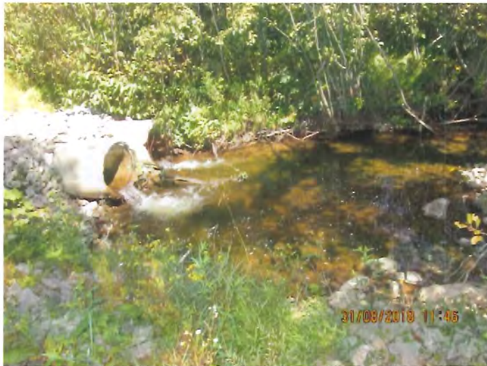
Photo 12; IMG_2912.JPG Léau est limpide à la sortie du ponceau en aval de la sablière
