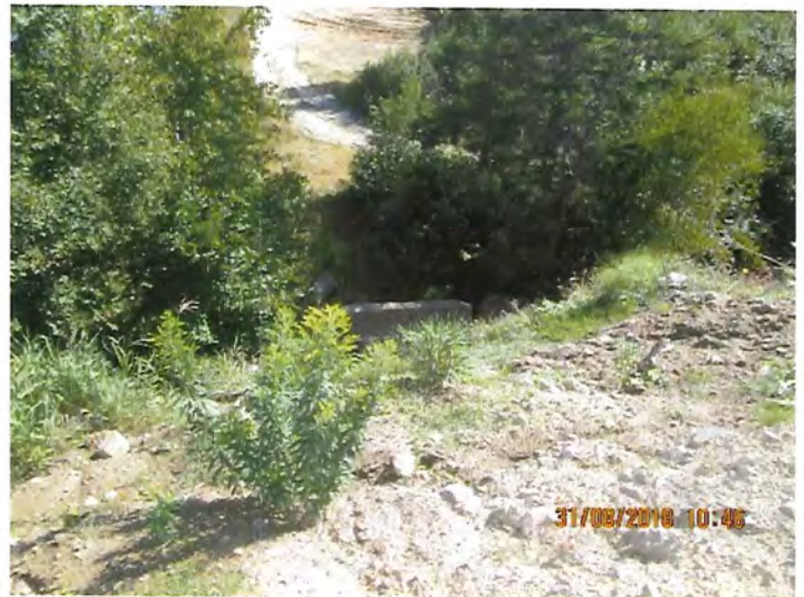
Photo 2 : IMG_2895.JPG Barrière en béton au bas du talus
