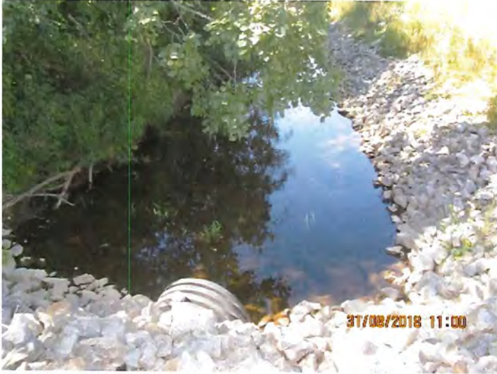
Photo 3; IMG_2896.JPG Enrochement et végétation autour du ruisseau
