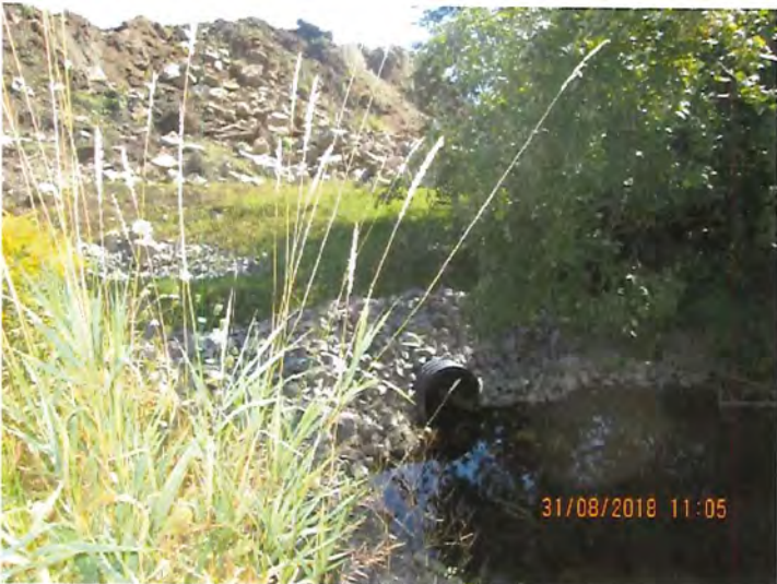
Photo 5 : IMG_2899.JPG L'eau est limpide vers le ponceau
