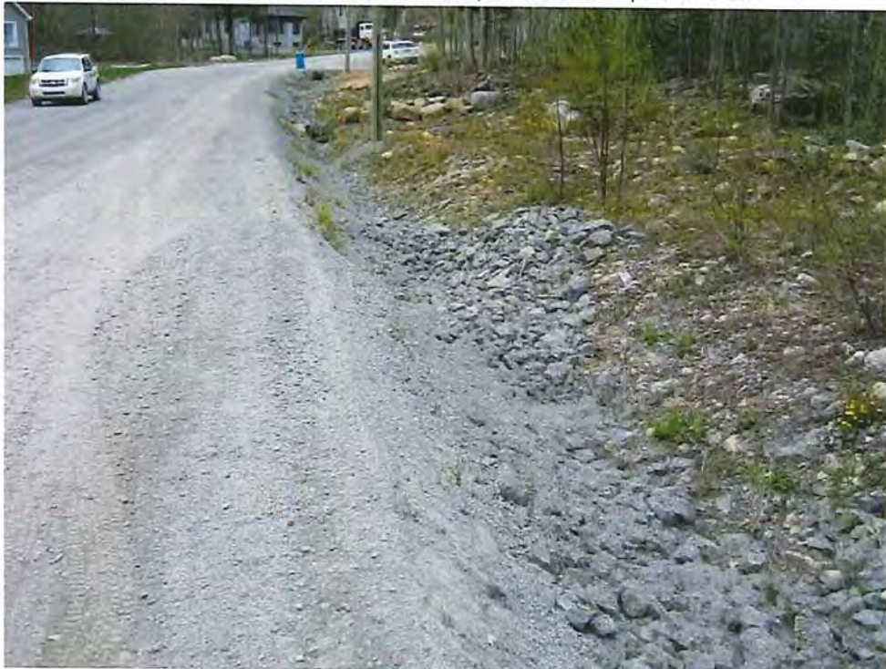
Photo 9 : Vue d'un bassin de sédimentation présent dans le fossé, en amont du ponceau situé au point GPS 007.
