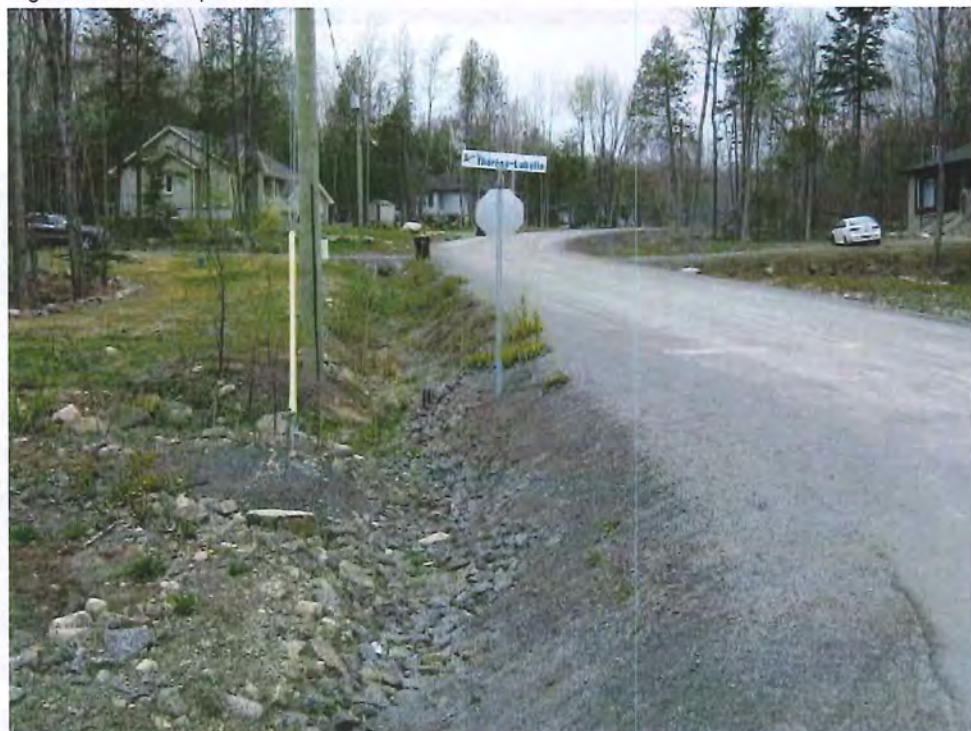
Photo 5 : Vue d'un fossé enroché et végétalisé situé au point GPS 008.
