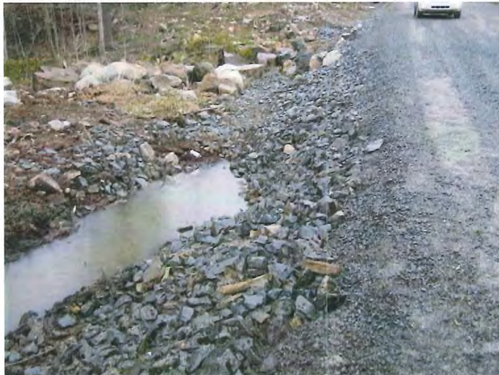
Photo 11 : Vue d'un bassin de sédimentation présent dans le fossé, en amont du ponceau situé au point GPS 010.
