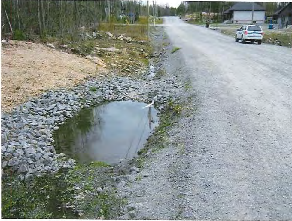
Photo 7 : Vue d'un bassin de sédimentation présent dans le fossé, en amont du ponceau situé au point GPS 007.
