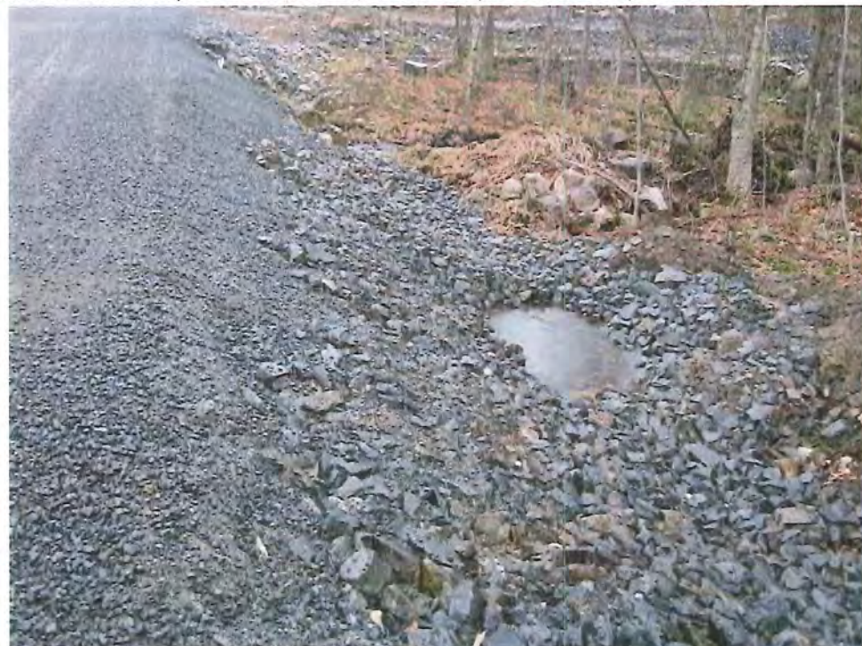
Photo 12 : Vue d'un bassin de sédimentation présent dans le fossé, en amont du ponceau situé au point GPS 010.
