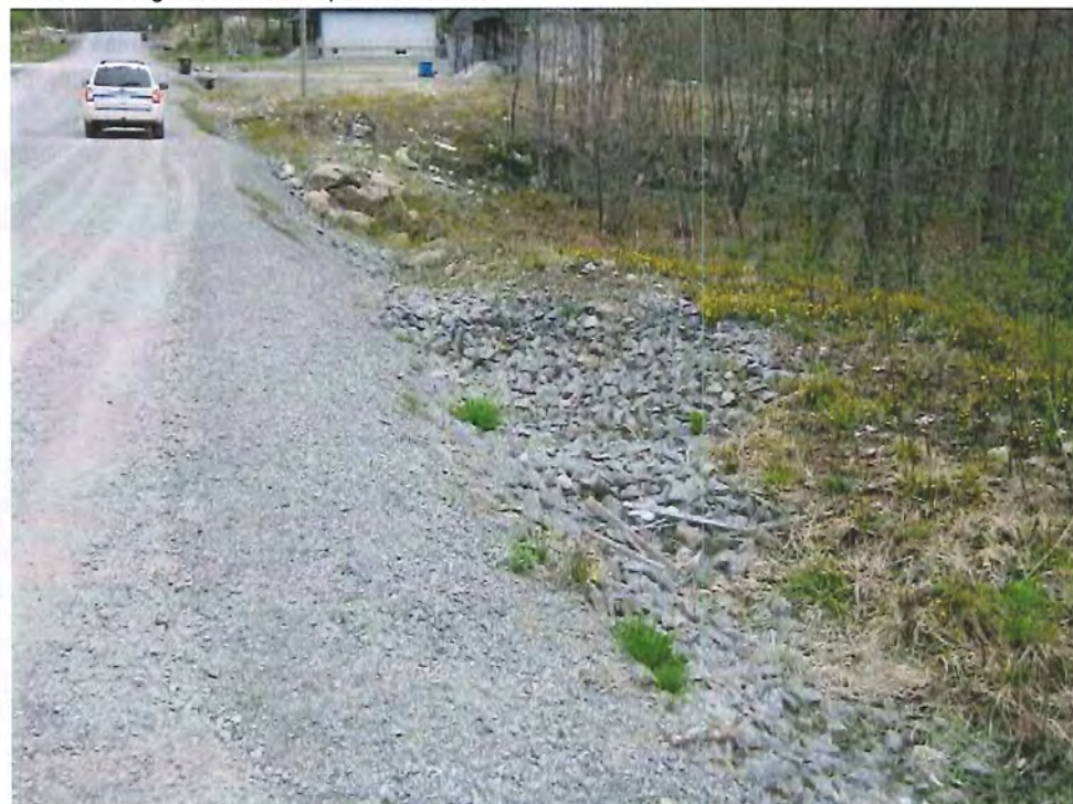
Photo 6 : Vue d'un bassin de sédimentation présent dans le fossé, en amont du ponceau situé au point GPS 007.
