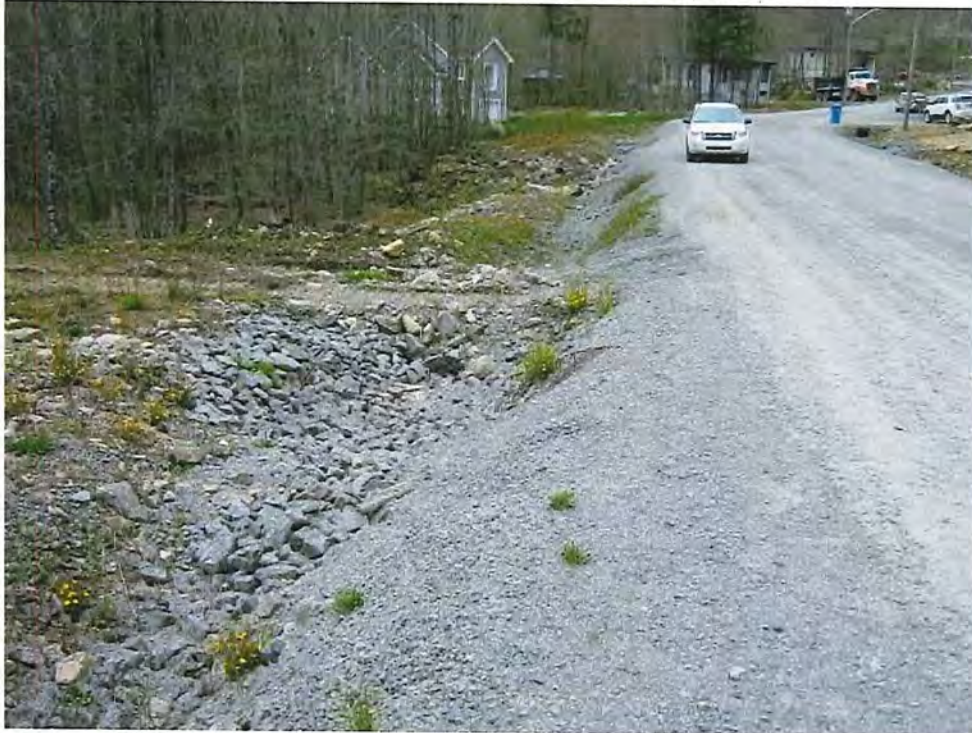
Photo 8 : Vue d'un bassin de sédimentation présent dans le fossé, en amont du ponceau situé au point GPS 007.
