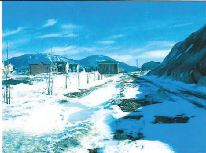
Photo 2 : Vu sur le côté nord du site. Présence du fossé existant à reprofiler et du chemin d'accès qui devait être du côté sud du site (sur le bord du ruisseau).
