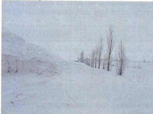
Photo 4 : Coté nord-est du site. Aucun chemin aménagé pour se rendre au bassin de décantation.
