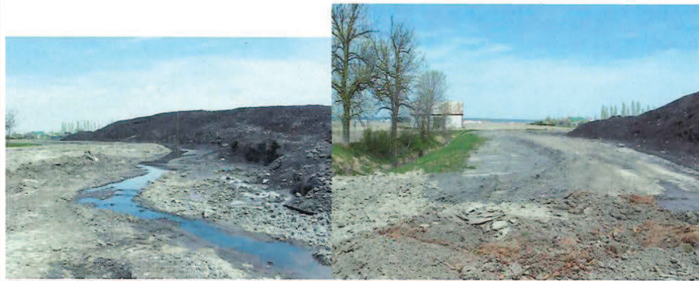
Photo 5 : Rigole aménagée à la base du dépôt de neige (Sud ouest du site). Photo 6 : Remblai en rive.
