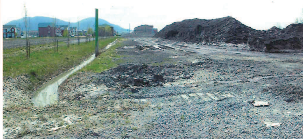
Photo 16-17 : Vu générale du terrain côté nord du site.
