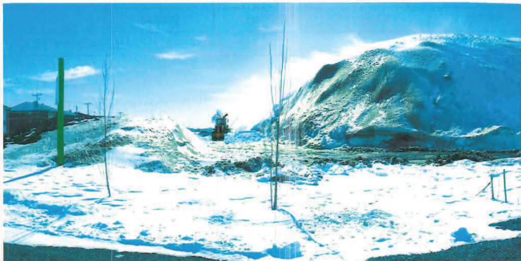
Photo 1 : Monticule sur le bord du Boulevard Yvon-l'Heureux (manque la plantation de conifère). Vu sur les travaux en cours de réalisation lors de mon inspection.
