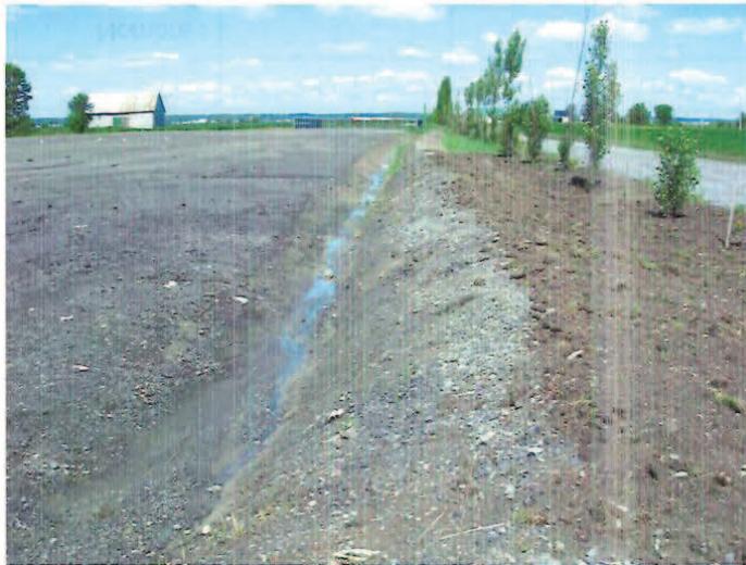
Photo 1 : Relocalisation du fossé et monticule de 200mm.
