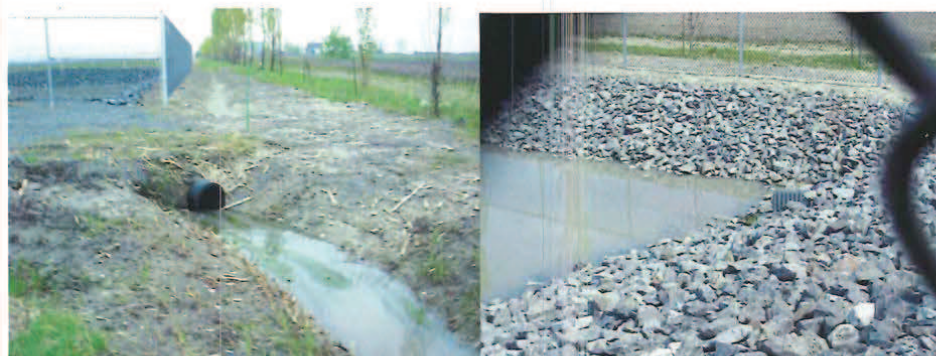
Photo 12 et 13: Entrée des eaux de fonte dans le bassin de décantation.
