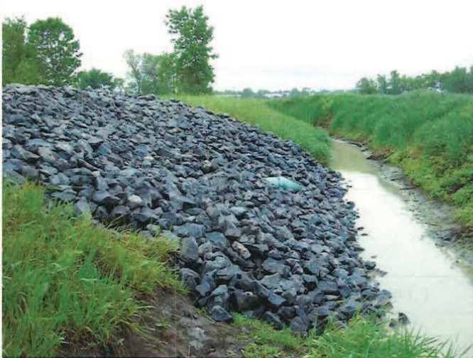
Photo 3 : Enrochement à l'émissaire pluvial.
