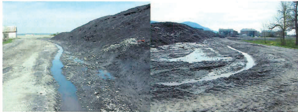
Photo 7 : Rigole (fossé) aménagée à la base du dépôt de neige (côté ouest). Photo 8 : Rigole aménagée pour diriger les eaux de fonte vers le bassin (côté ouest).
