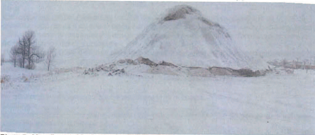
Photo 5 : Vue d'ensemble du site de dépôt à neige.
