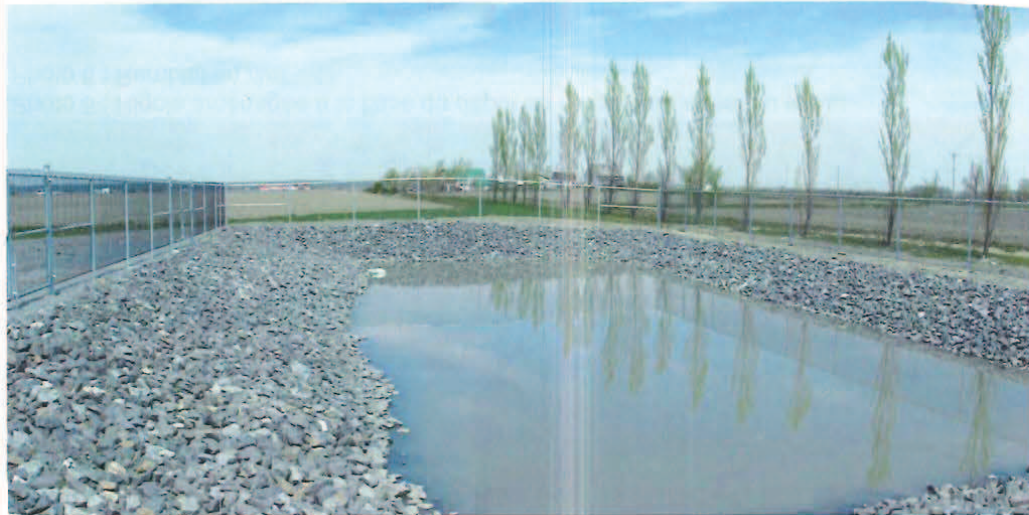
Photo 10-11 : Bassin de décantation.
