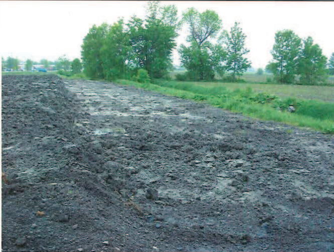
Photo 2 : retrait du remblai dans la rive du ruisseau des trente.
