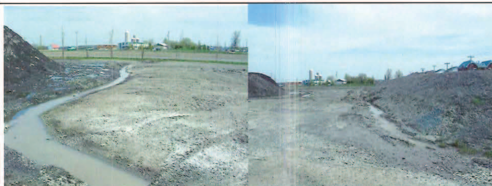
Photo 18 : Rigole aménagée du côté Sud est du site
