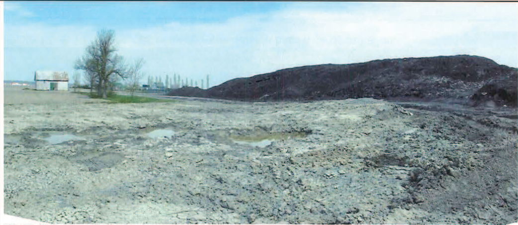
Photo 3-4 : Vu générale du remblai sur le site.
