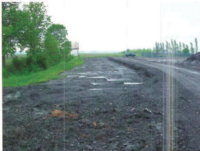
Photo 1 : Retrait du remblai dans la rive du ruisseau des trente.
