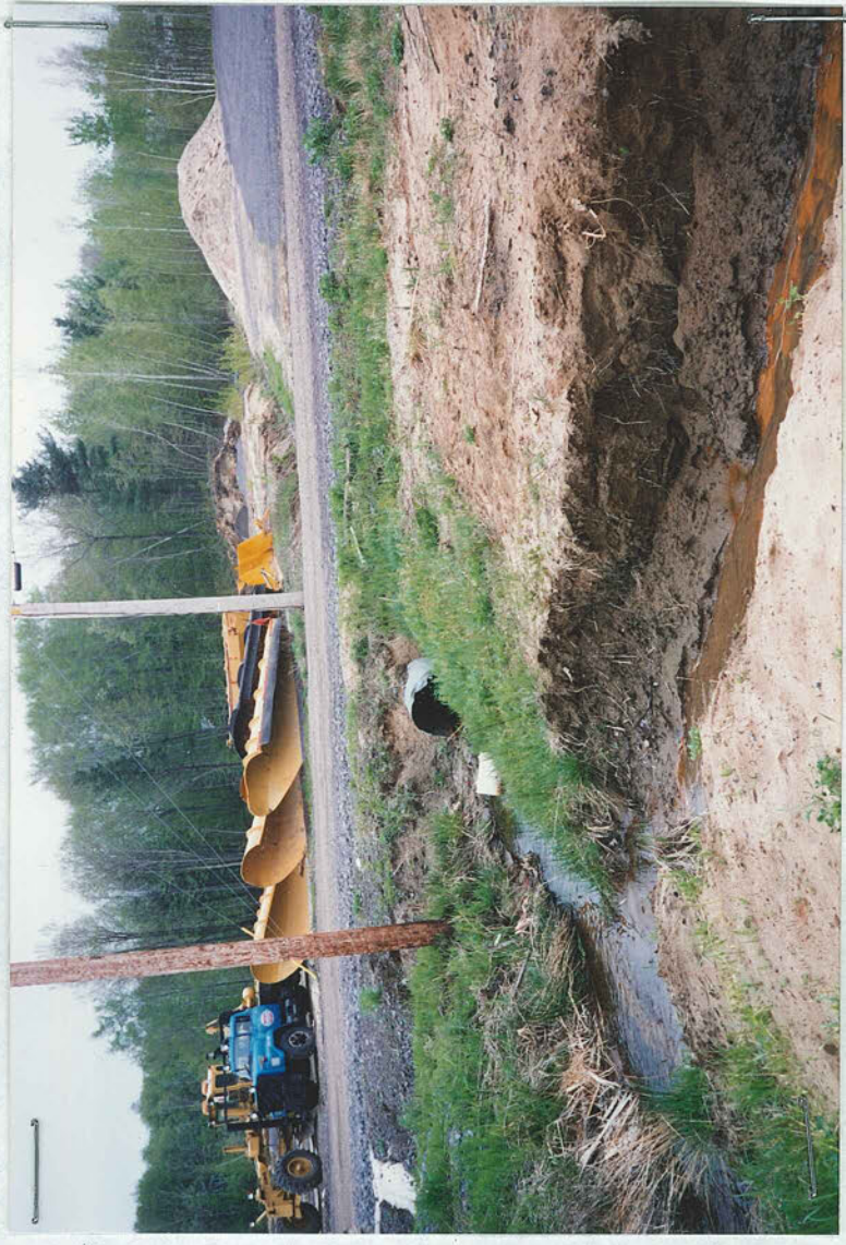
#9. volet du fossé de drainage dans le fossé principal (décharge de lae)
