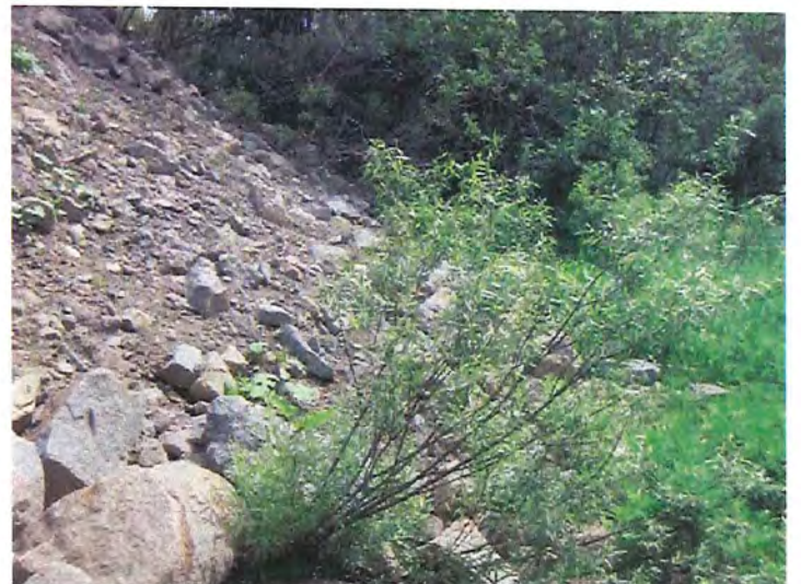
4. Le talus du remblai et un partie du MH
