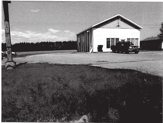
DSCF0102 (640x480).jpg Image 4. Fossé devant le 1239, route 265
