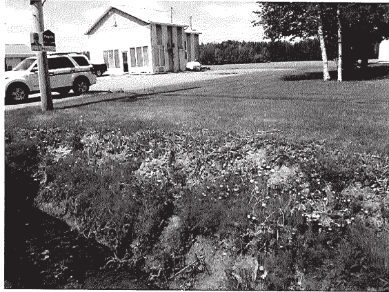
DSCF0100 (640x480).jpg Image 2. Fossé devant le 1237, route 265
