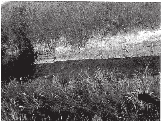
DSCF0104 (640x480).jpg Image 6. Fossé devant le 1241, route 265
