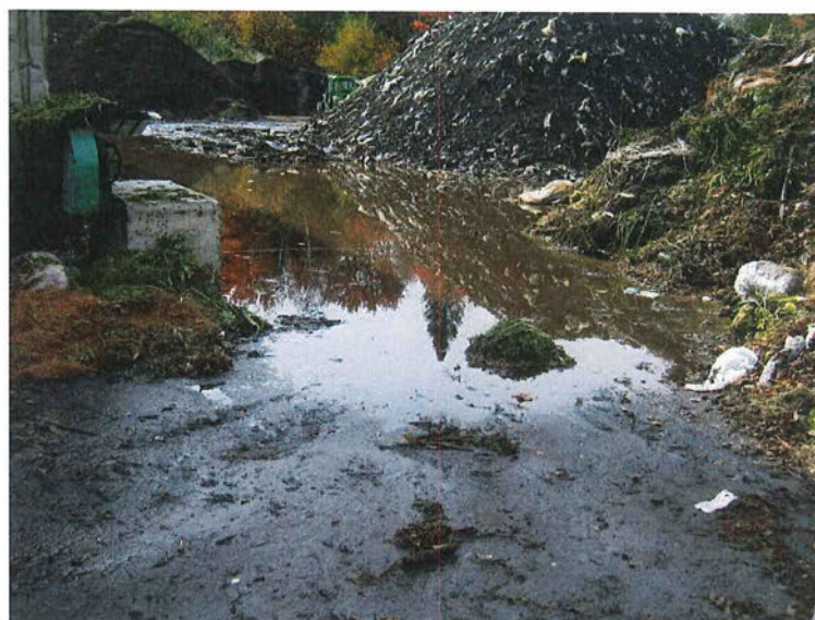
Photo 3. Le drain qui dessert les plates-formes d'entreposage extérieures était colmaté lors de l'inspection.
