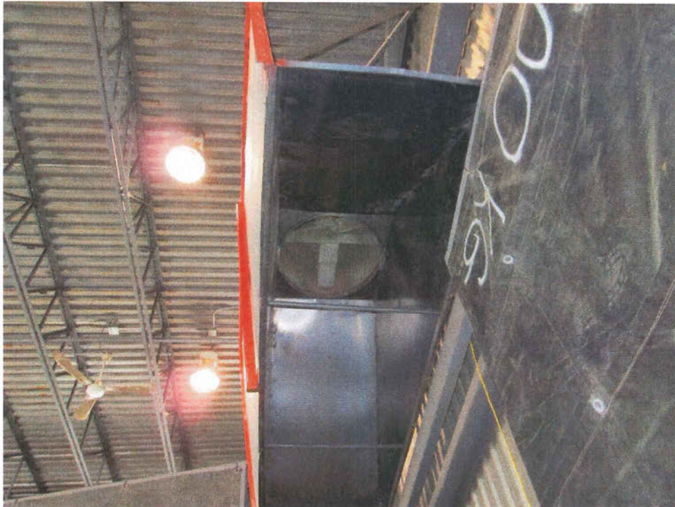
Photo 5. Ventilateur du système de captage de la cheminée, aucun filtre n'est en place
