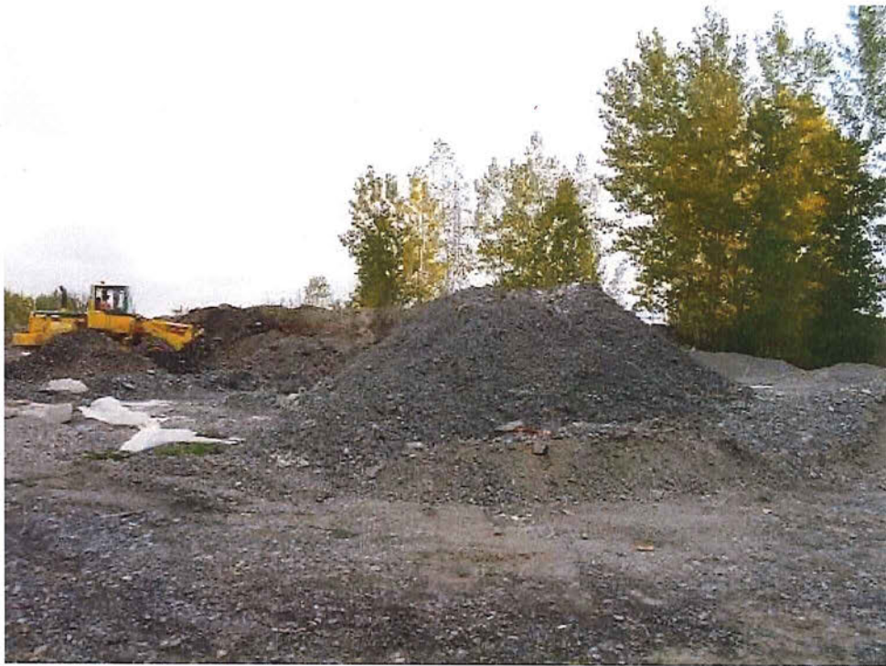
DSCN4050 (640x480).jpg 11. Entreposage gravier et sols excavés.
