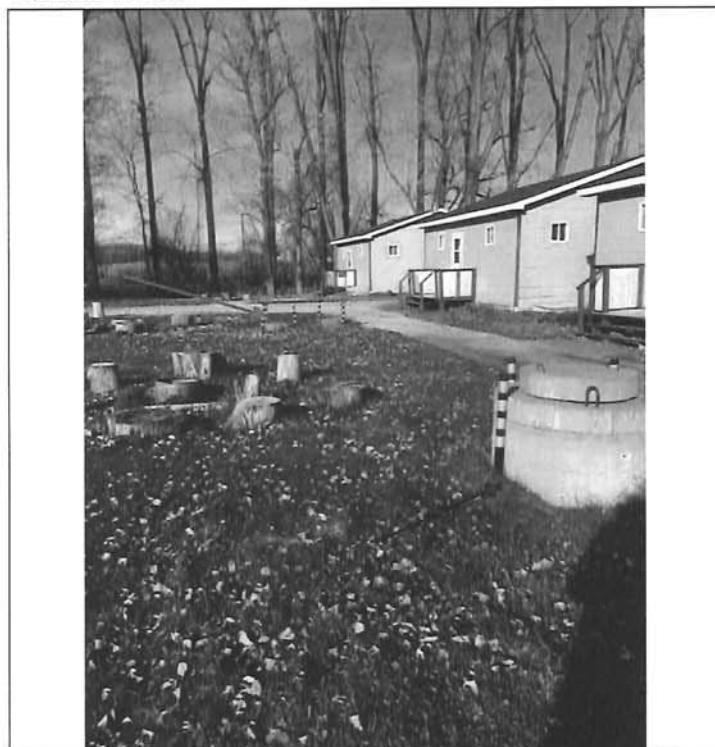
IMG_0429.JPG Flèche rouge: fosse face au chalet 2, flèche mauve: poste de pompage
