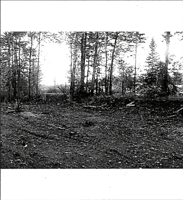
Image 9: Le remblai a été mis sur 53-54
