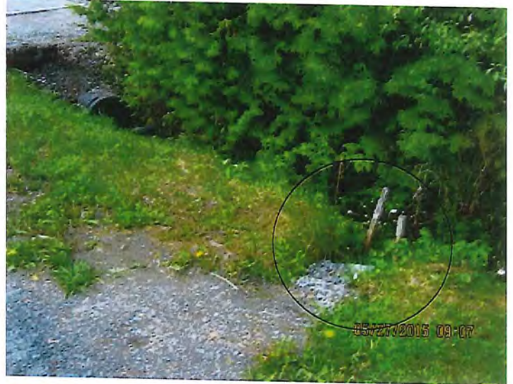
4. Un trou a été creusé et rempli de pierres concassées pour faciliter l'écoulement de l'eau du stationnement vers le cours d'eau (IMG_0543.jpg).
