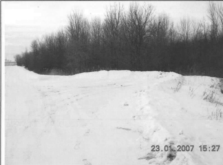
Photo 4 : Déblais de la neige au pourtour de la voie ferrée (GPS 2)
