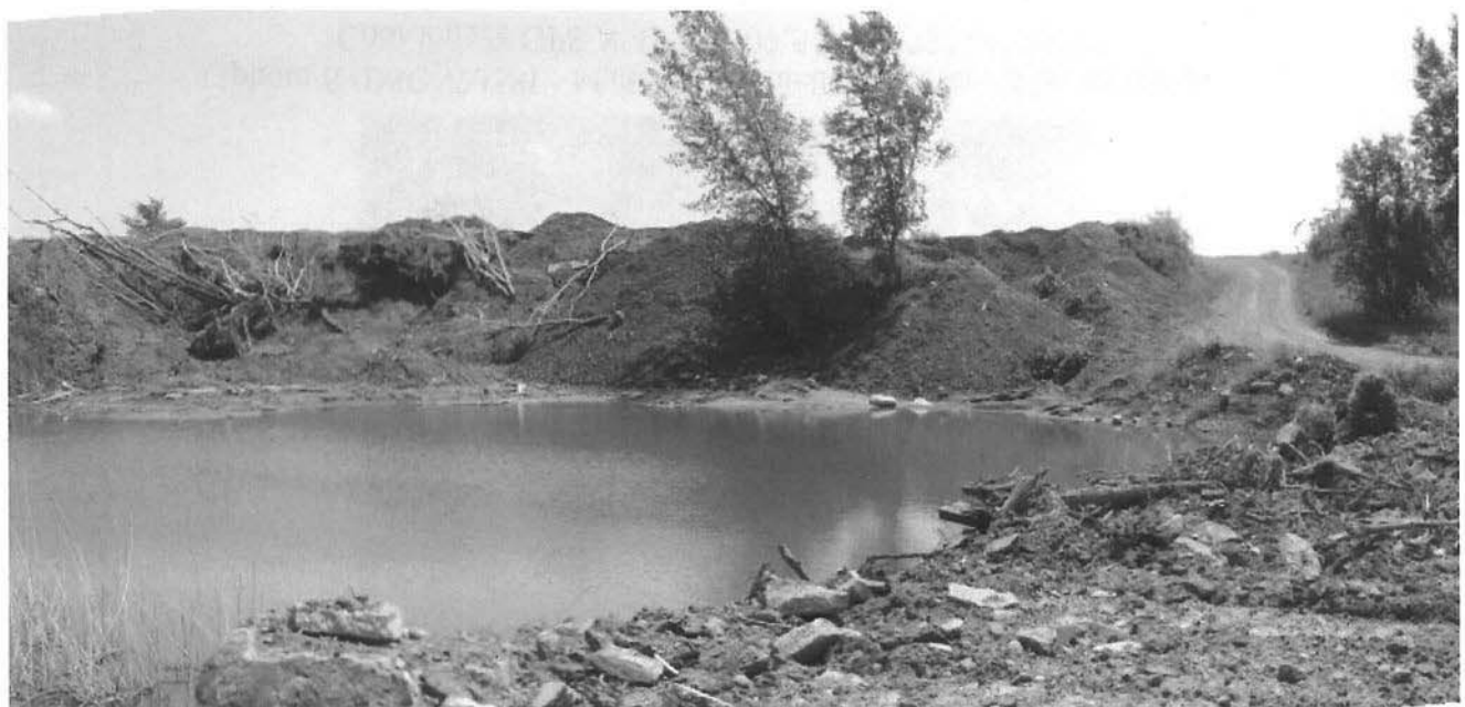
photo 3 (DSCN2360, 61) : Remblai en empiètement dans un étang. Le remblai dans l'étang s'étend sur une distance approximative de 60 mètres (m).
