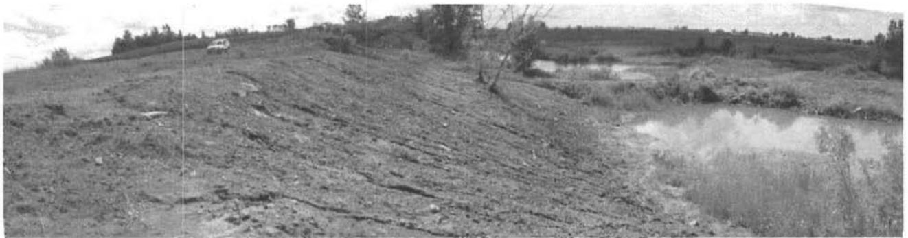
photo 1, DSCN6896, ..., 6900 : Vue de profil du talus restauré, la pente est de 1 V : 1,5 H et un ensemencement à la volée a été effectué.
