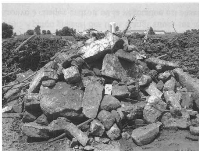
photo 7 (DSCN2372) : Matières résiduelles, béton en vrac, armatures de métal, en quantités appréciables dans les amas présent sur le site.
