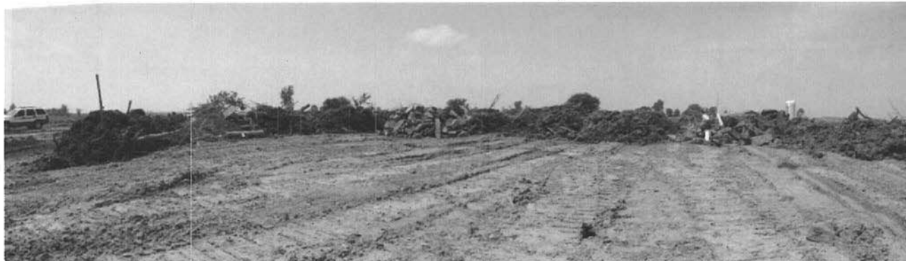
photo 5 (DSCN2374, 75, 76, 77, 78) : Amas, constitués de terre, roches, souches et matériaux secs tel que béton et acier, entreposés sur le lieu du remblaiement.
