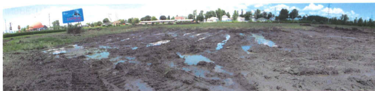
photo 2, DSCN4735, 36, 37, 38, 39 : Marais isolé entièrement fauché par un engin de terrassement lourd muni d'un déchiqueteur. L'eau provient de la nappe phréatique.
