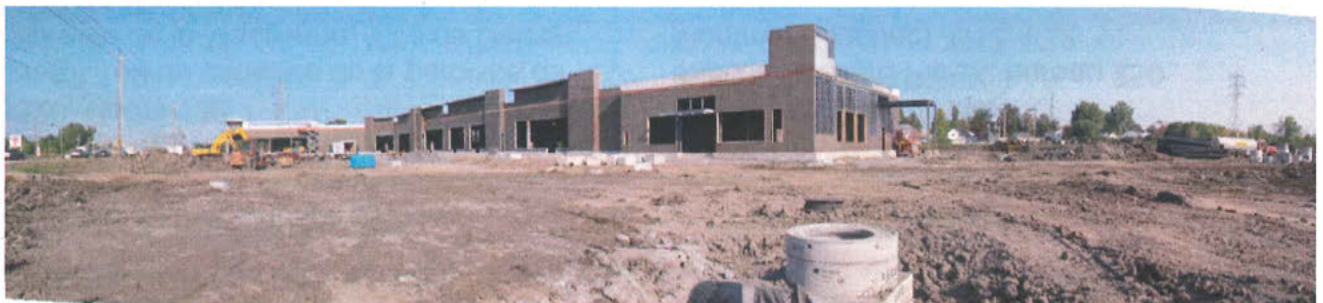
photo 1, 7430-16-01-0341400 DSCN7212, ..., 7218 : Vue panoramique du site, un bâtiment commercial est en construction et les regards d'égouts ainsi que des bornes-fontaines sont présentes sur le site.
