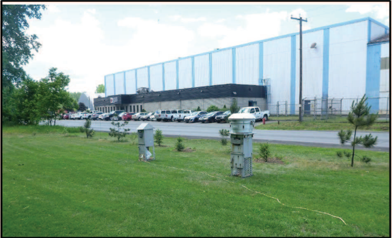
Photographie 3 : Site d'installation des instruments à l'aval-1, 205 Rang Nord (Station 2).
