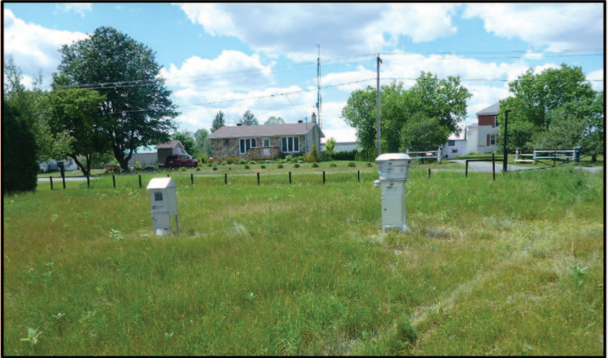
Photographie 5 : Site d'installation des instruments à l'aval-3, 175 Rang Nord (Station 4).
