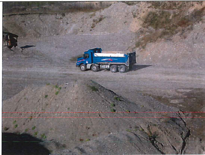
Identification : Autre camion benne qui entre dans la sablière pour le chargement
