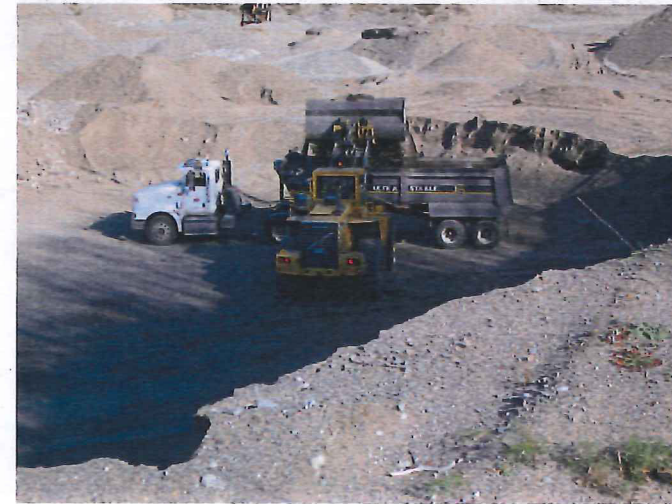
Identification : Camion remorque appartenant à excavation LMR qui se fait charger
