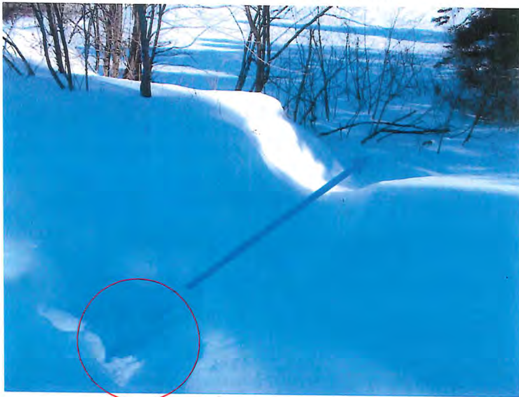
Photo no. 3 : Exutoire des eaux de fonte après traitement. Cercle rouge, localisation du Stormceptor qui devait être selon les plans dans le bassin de décantation. De plus, il ne semble pas y avoir une conduite mais plutôt un fossé de rejet des eaux de fontes après le Stormceptor. Flèche bleue : Sens d'écoulement des eaux après traitement. Le fait d'avoir évité la mise en place d'une conduite pourrait causer de l'érosion excessive des rives de la Rivière du Nord. Impossible de lire ce qui est inscrit sur le couvercle du pluvial à cause de la glace.
