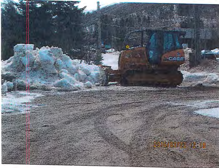
IMG_3725.JPG Bouteur sur place.
