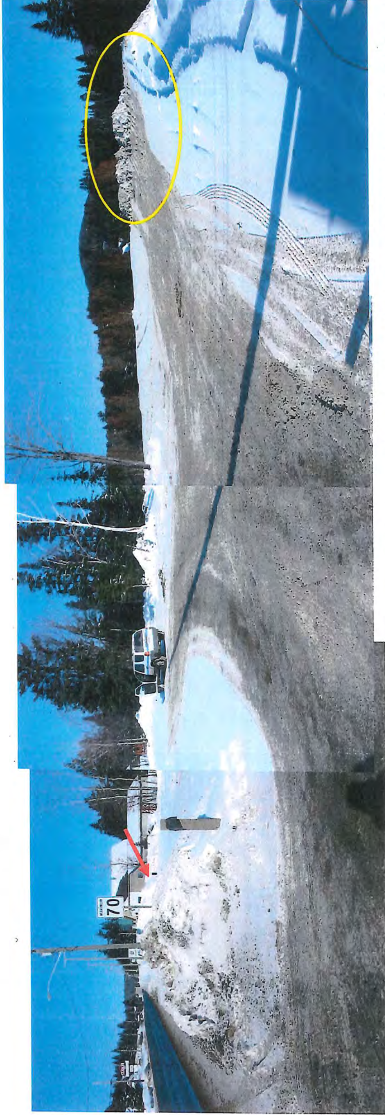
Photo no 1 : Vue générale des lieux. À gauche la route 117. Flèche rouge : Localisation du piézomètre F-1 sur les plans. Cercle jaune : La neige est poussée dans le talus en direction du bassin de sédimentation.
