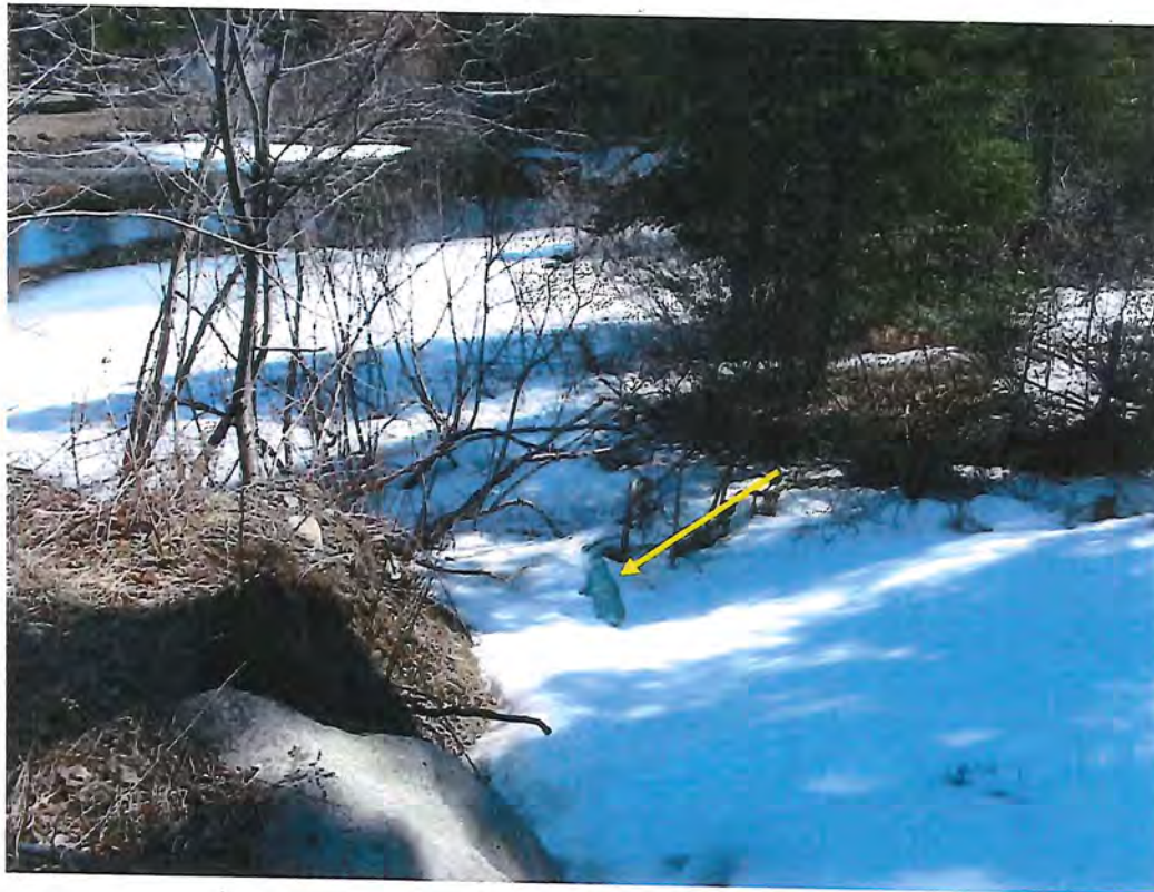
Photo no. 2 : La conduite au point de rejet est en place. Il avait été impossible d'observer sa présence lors d'inspections précédentes.
