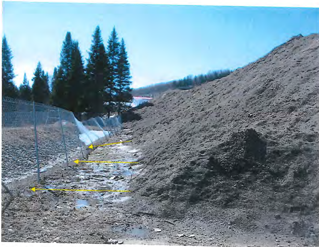
Photo no. 4 : Amas de neige en cours de fonte et clôture endommagée par les blocs de neige qui ont déboulés en bas de la pente. La pente du terrain fait en sorte que les eaux de fonte sont acheminées dans le bassin de sédimentation comme prévu. Le bassin était vide lors de l'inspection. L'eau semble percoler dans le sol. Flèches jaunes :sens d'écoulement de l'eau de fonte.
