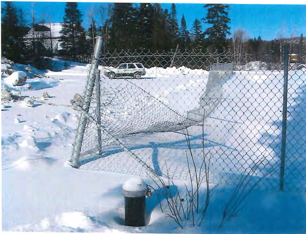
Photo no. 2 : La clôture a été endommagée probablement par le poids de la neige de l'hiver précédent. En avant-plan, le piézomètre (F-5) cadenasé. La neige déversée se trouve à gauche.
