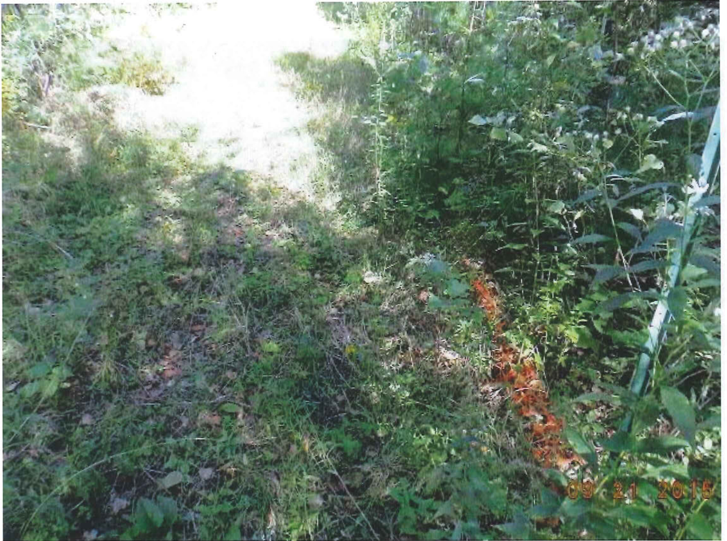
DSC05080 (640x480).jpg Exemple de clôture affaissée au sol
