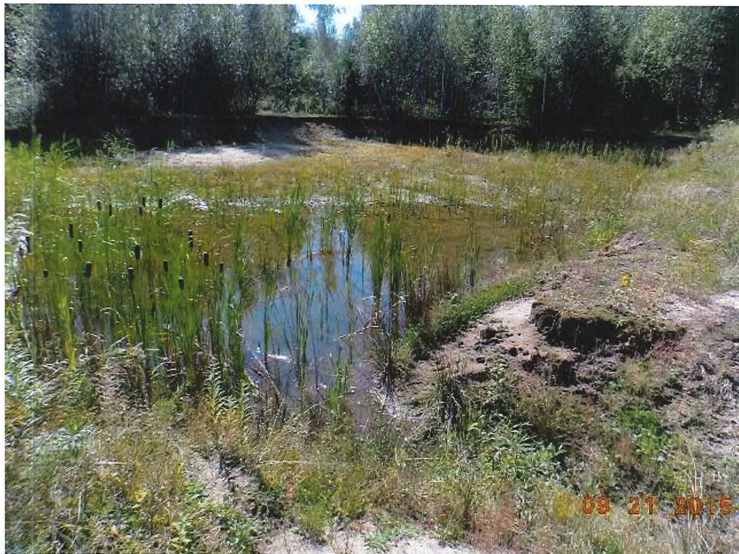
DSC05101 (640x480).jpg Bassin de biorétention numéro 3
