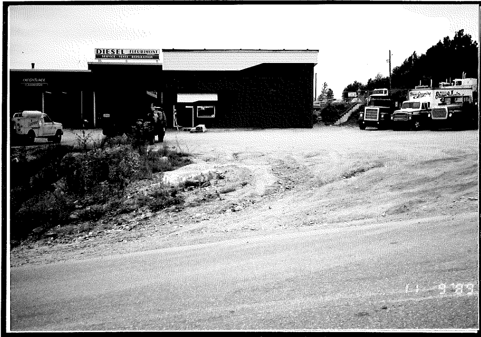
1 Vue de l'extérieur
