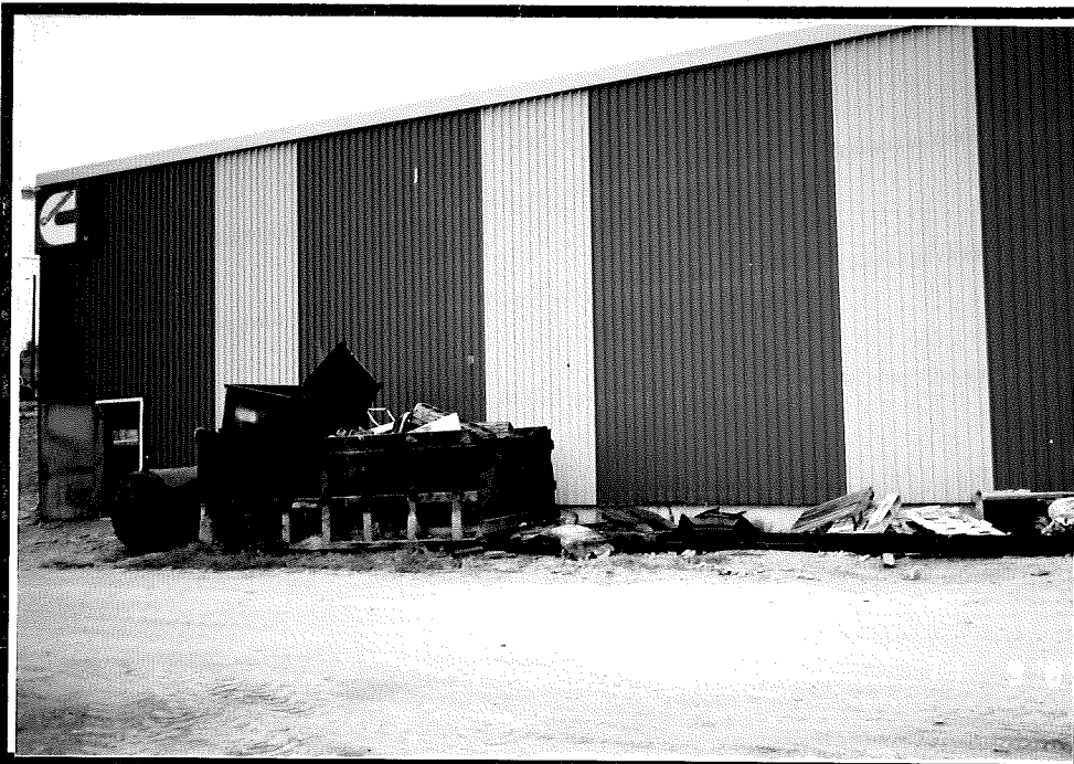
8 Vue de l'extérieur (côté de l'usine)
